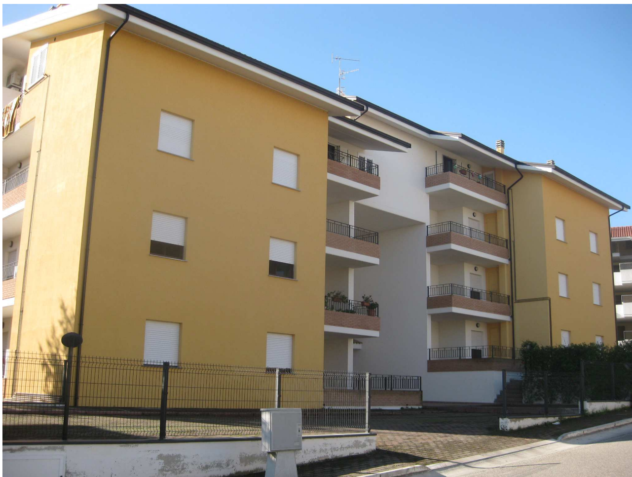
Foto n° 3: Vista del fronte nord del fabbricato su cui insistono gli immobili oggetto di stima
