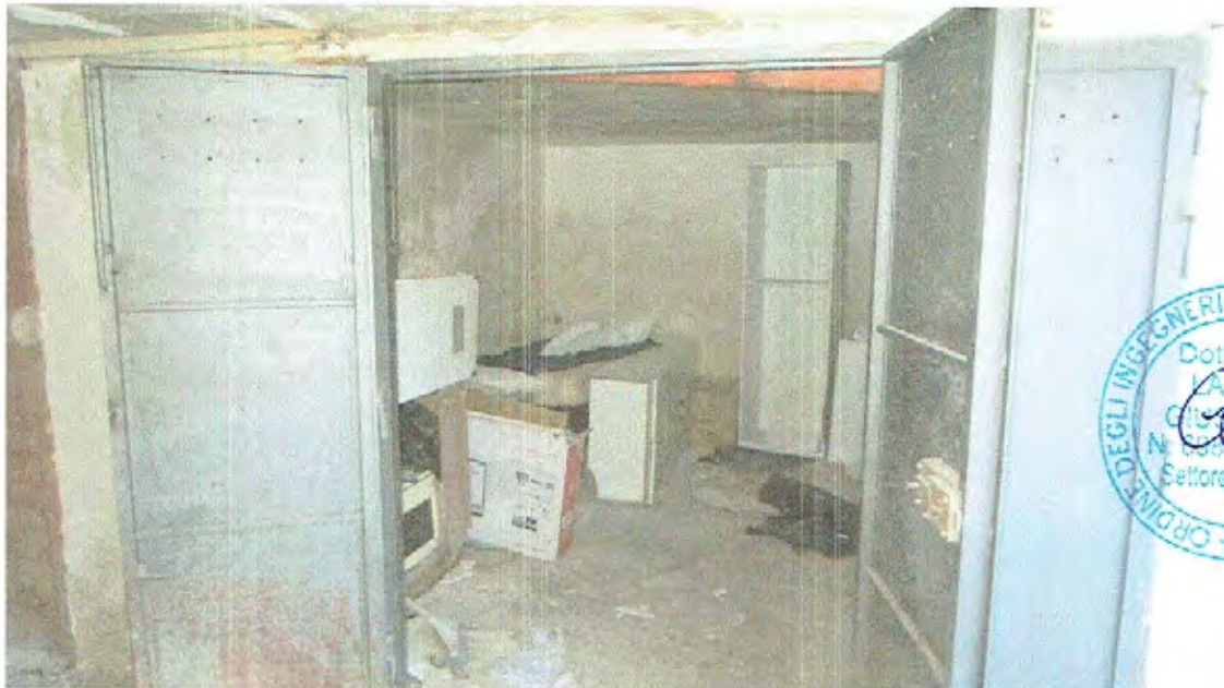
Foto n.33 - Unità Immobiliare n.3 (Piano S2 - Interno garage )
