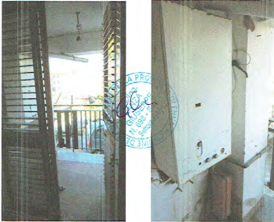
Foto n.17 - Terrazzino di Accesso dal Vano Cucina
