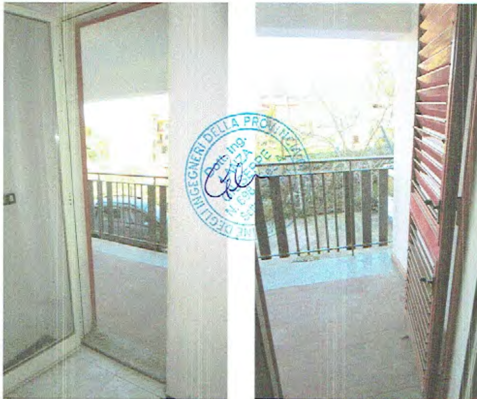
Foto n.21 - Terrazzino di Accesso dal vano Soggiorno
