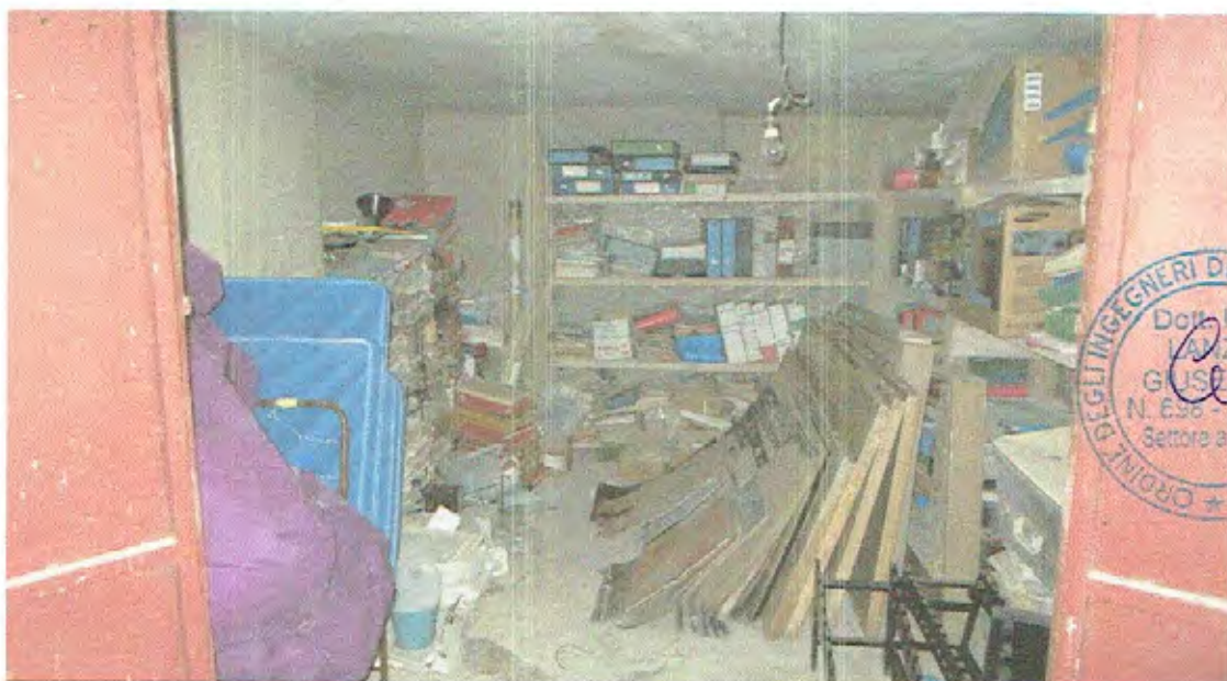
Foto n.38 - Unità Immobiliare n.5 (Piano S2 - Interno Garage)
