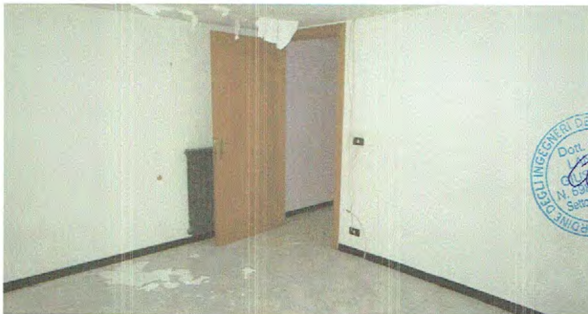
Foto n.27 - Vano Camera da Letto
