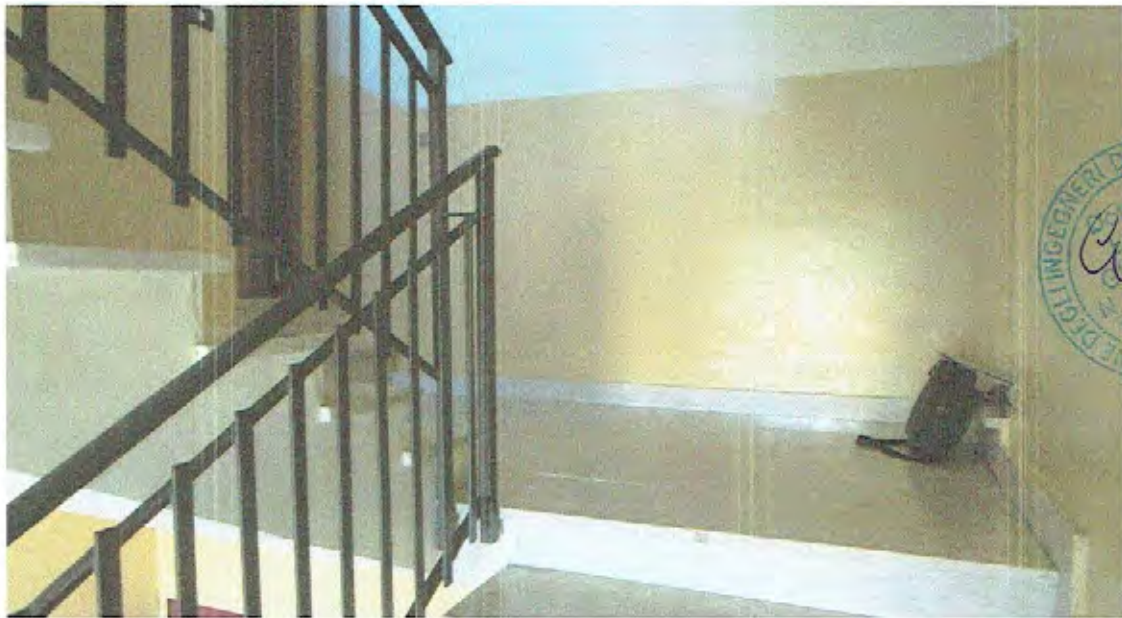
Foto n.08 - Scala Condominiale (Piano S1 - Pianerottolo di accesso alle U.I. n.1 e n.2)
