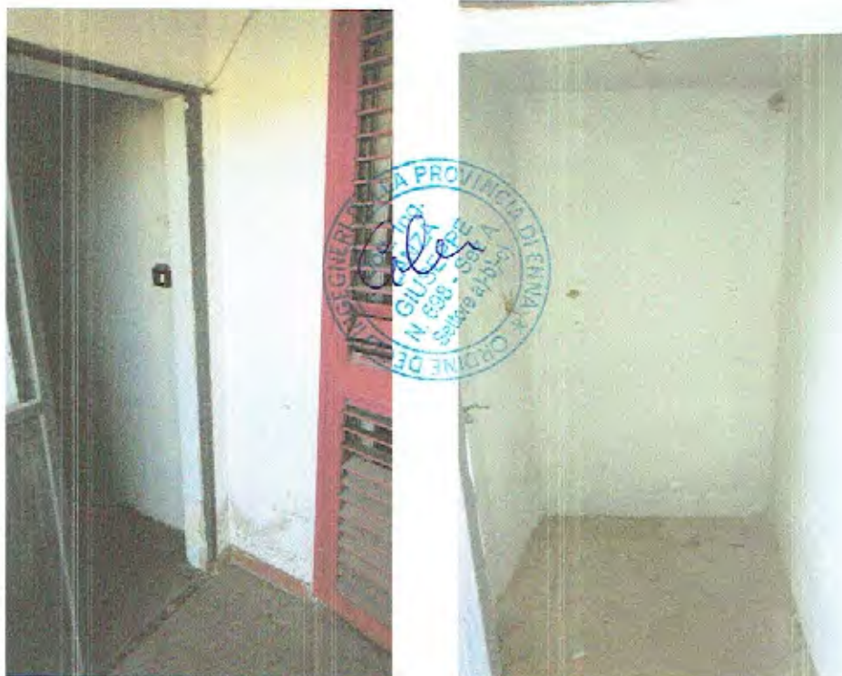
Foto n.18 - Vano Ripostiglio di Accesso dal Terrazzino
