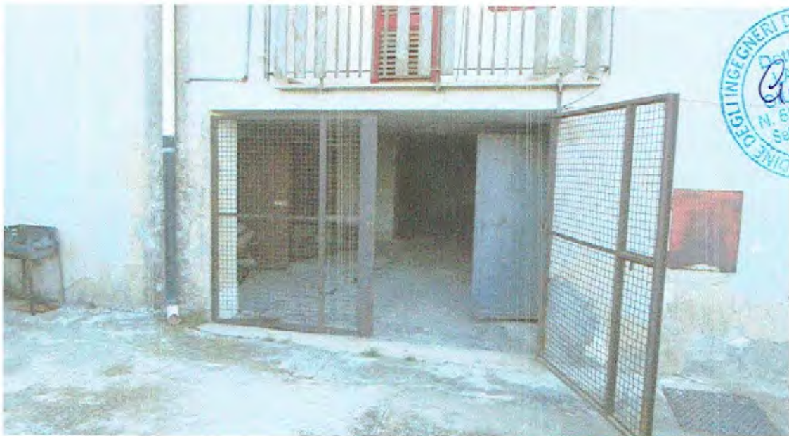
Foto n.30 - Prospetto Ovest (Piano S2 - Entrata con Corridoio di Manovra )
