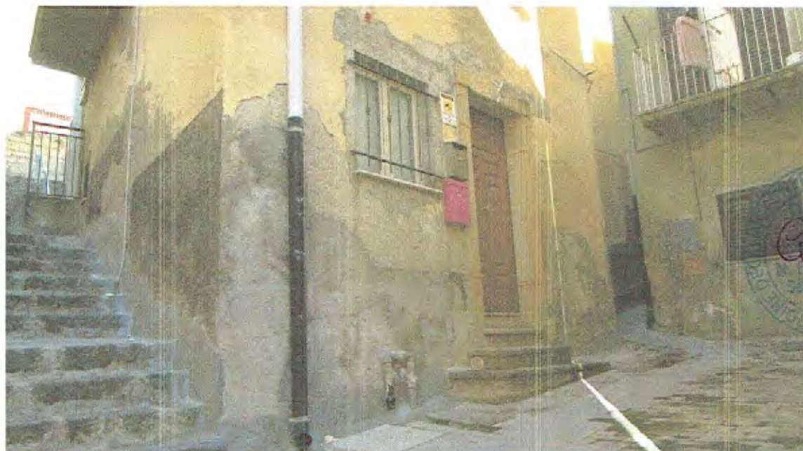
Foto n.14 - Prospetto Sud (Piano Terra - Entrata)
