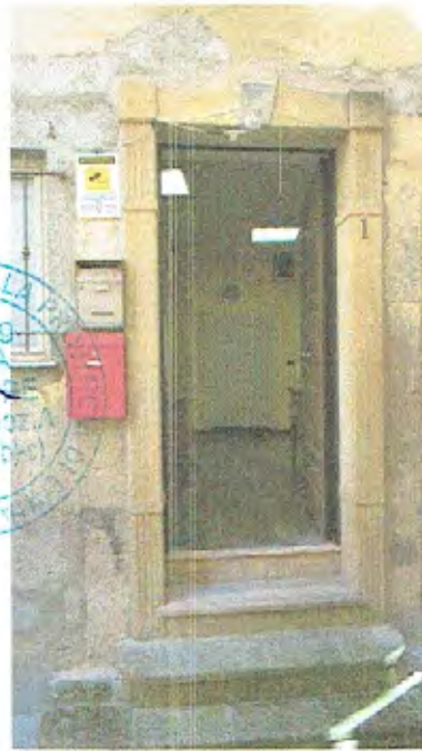
Foto n.17 - Prospetto Sud (Piano Terra - Entrata)
