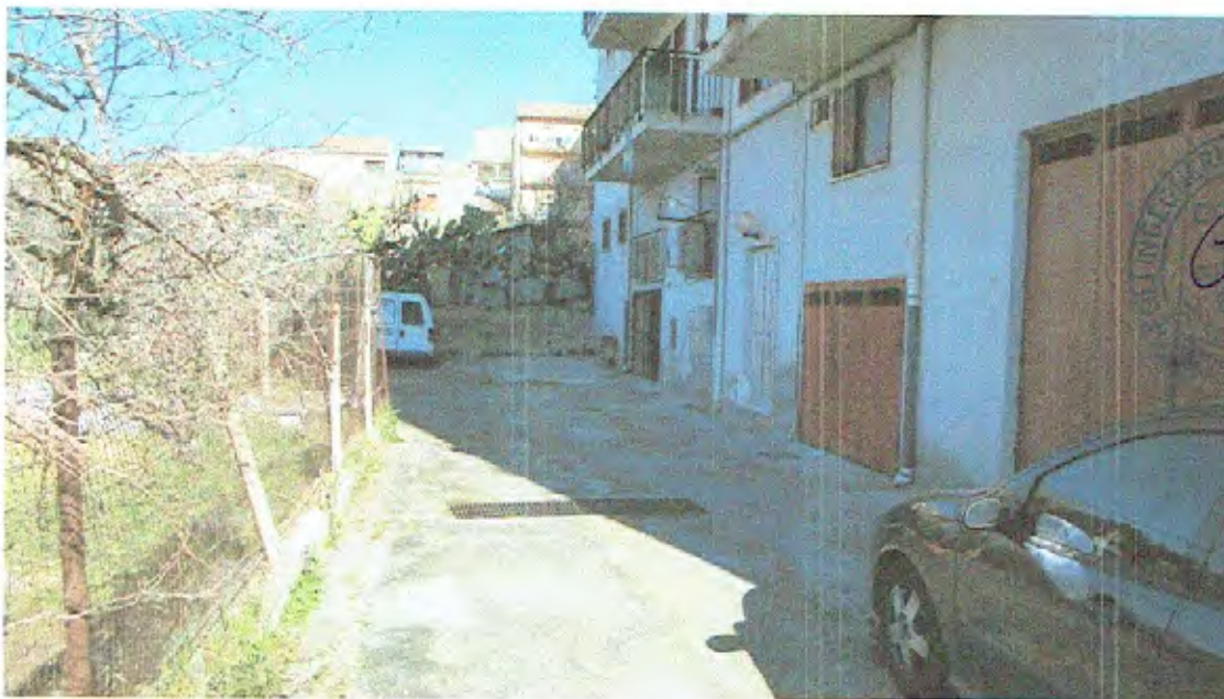
Foto n.05 - Prospetto Ovest (Piano S1 - Unità Immobiliare n.1 e n.2)
