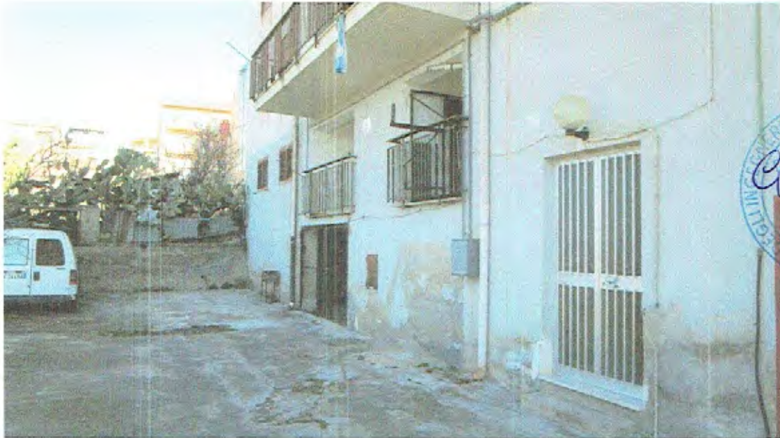
Foto n.07 - Prospetto Ovest (Piano S2 - Ingresso Secondario Scala Condominiale)
