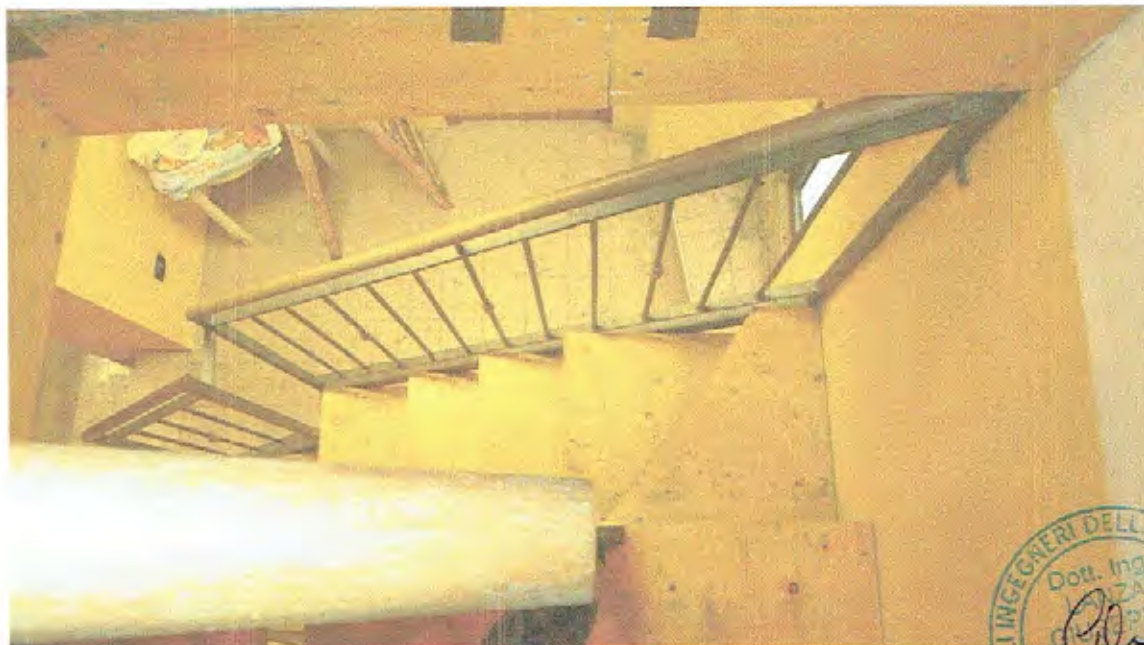
Foto n.08 - Vano Scala (Ferro-Legno) (Comunicante con U.I. n.9)
