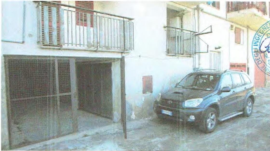
Foto n.29 - Prospetto Ovest (Cancello di Accesso)
