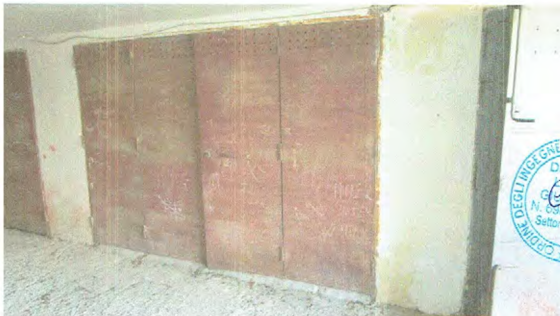
Foto n.37 - Unità Immobiliare n.5 (Piano S2 - Entrata Garage)
