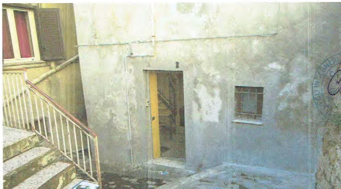
Foto n.02 - Prospetto Est (Piano Terra - Entrata)
