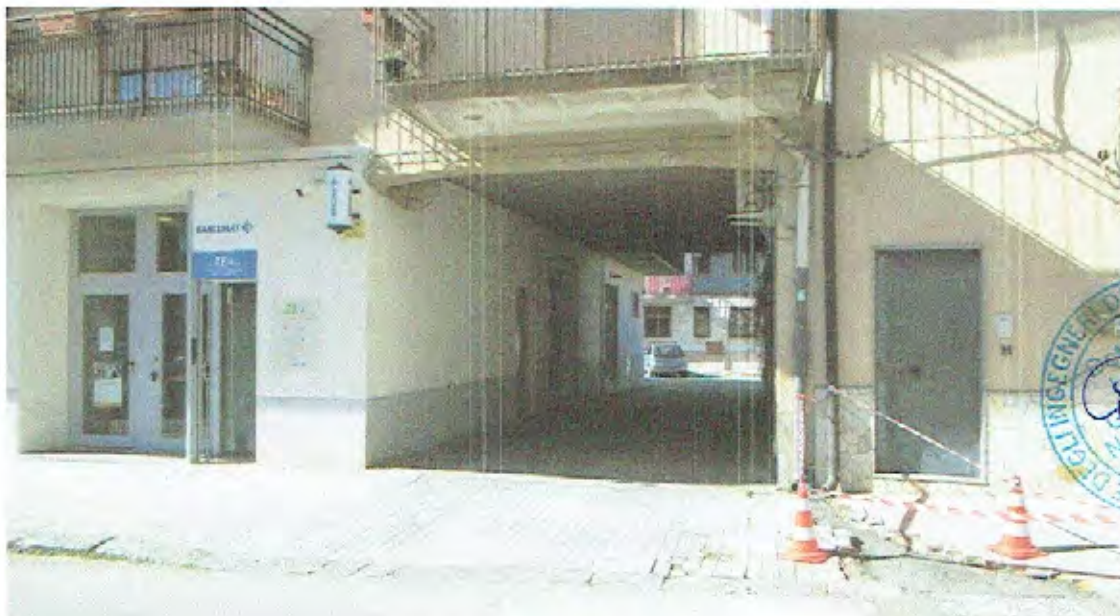
Foto n.04 - Via Roma (Sottopassaggio di Comunicazione al Piazzale di Accesso alle U.I.)
