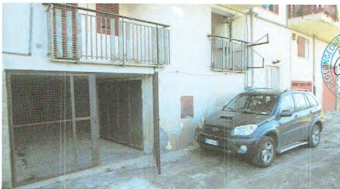
Foto n.06 - Prospetto Ovest (Piano S1 - Unità Immobiliare n.1 e n.2)
