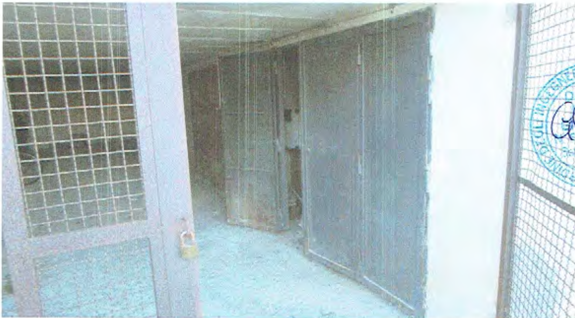
Foto n.32 - Unità Immobiliare n.3 (Piano S2 - Entrata Garage )
