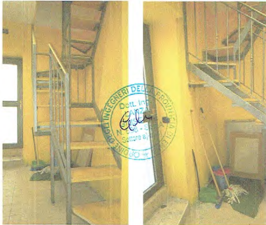
Foto n.06 - Scala Interna in Ferro-Legno (Comunicante con U.I. n.9)
