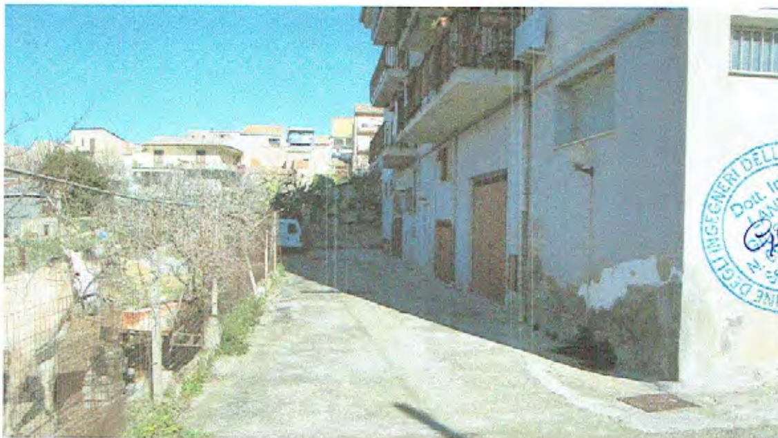
Foto n.01 - Prospetto Ovest (Strada Pertinenziale di Accesso alla U.I.)
