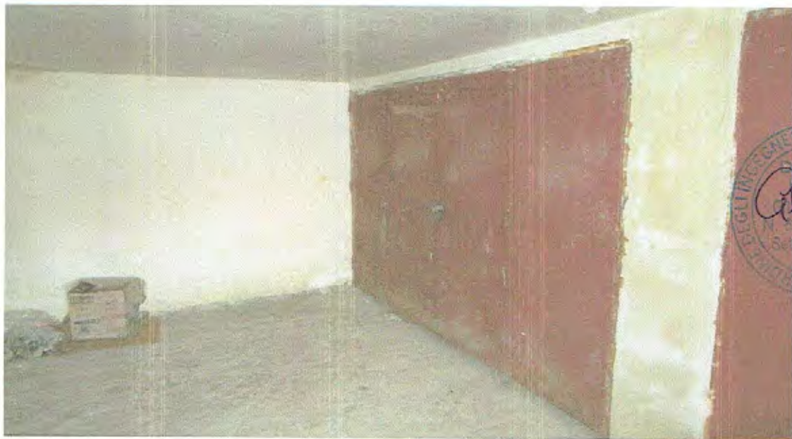
Foto n.34 - Unità Immobiliare n.4 (Piano S2 - Entrata Garage )
