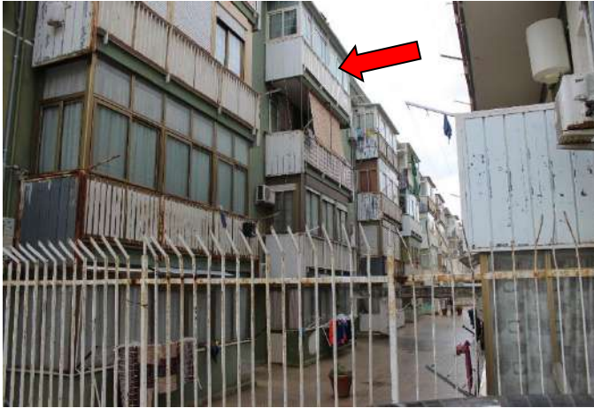
Retroprospetto dell'edificio scala A, a confine con la corte condominiale
