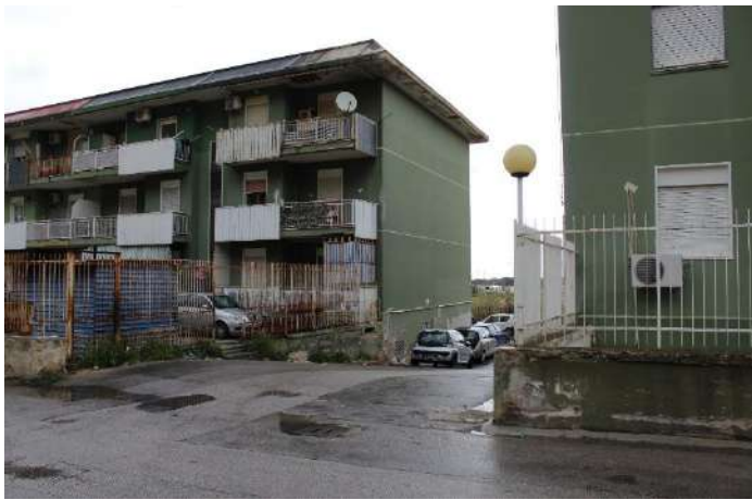
Strada di accesso dalla via Ciaculli
