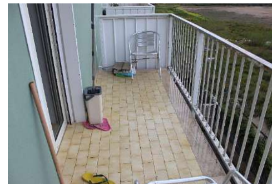
Vista del balcone su fronte principale
