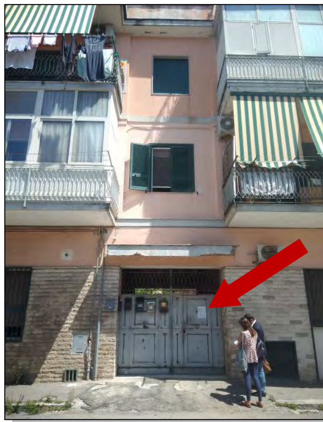
Foto n. 2 – Portone d'ingresso al fabbricato in Via G. Arenella n. 23
