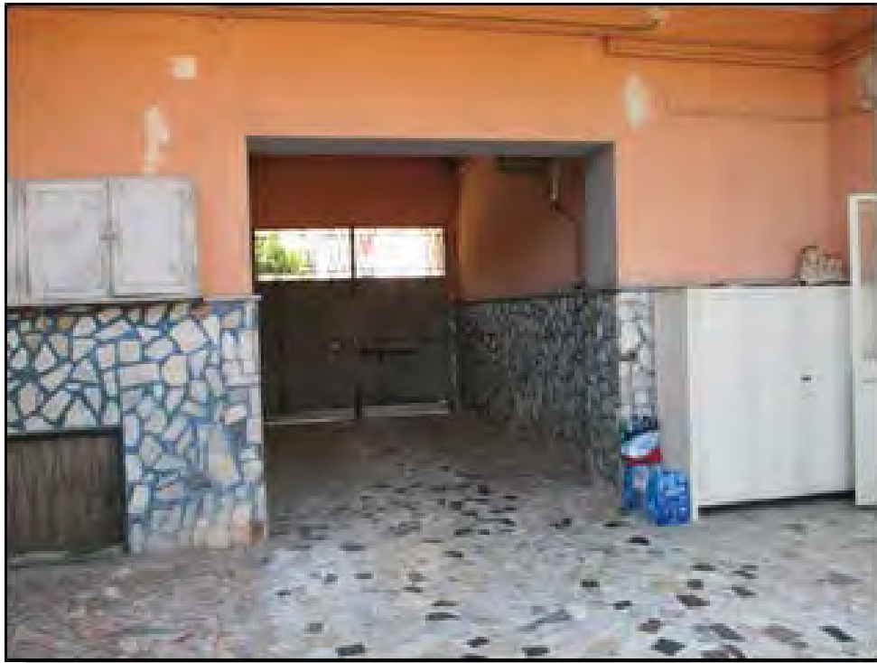
Foto n. 5 – Androne interno al fabbricato in Via G. Arenella n. 23
