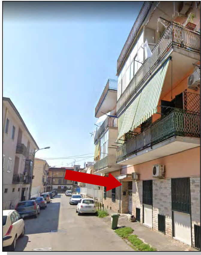
Foto n. 1 – Fabbricato in Via G. Arenella n. 23
