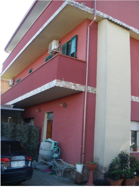
Foto n. 03: Prospetto posteriore del fabbricato
