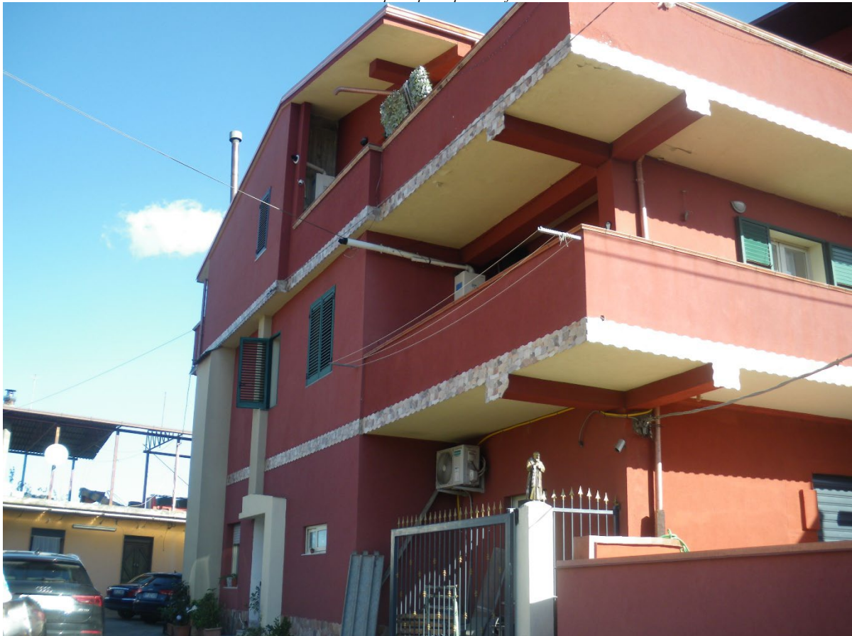
Foto n. 02: Prospetto laterale del fabbricato
