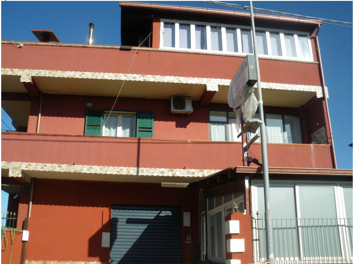
Foto n. 01: Prospetto principale del fabbricato
