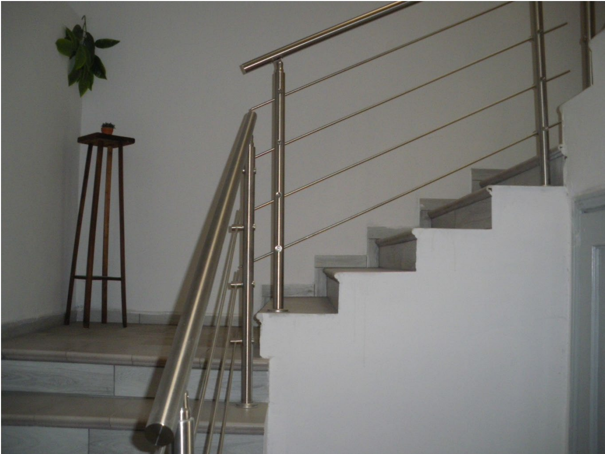
Foto n. 05: Scala di collegamento al piano verticale
