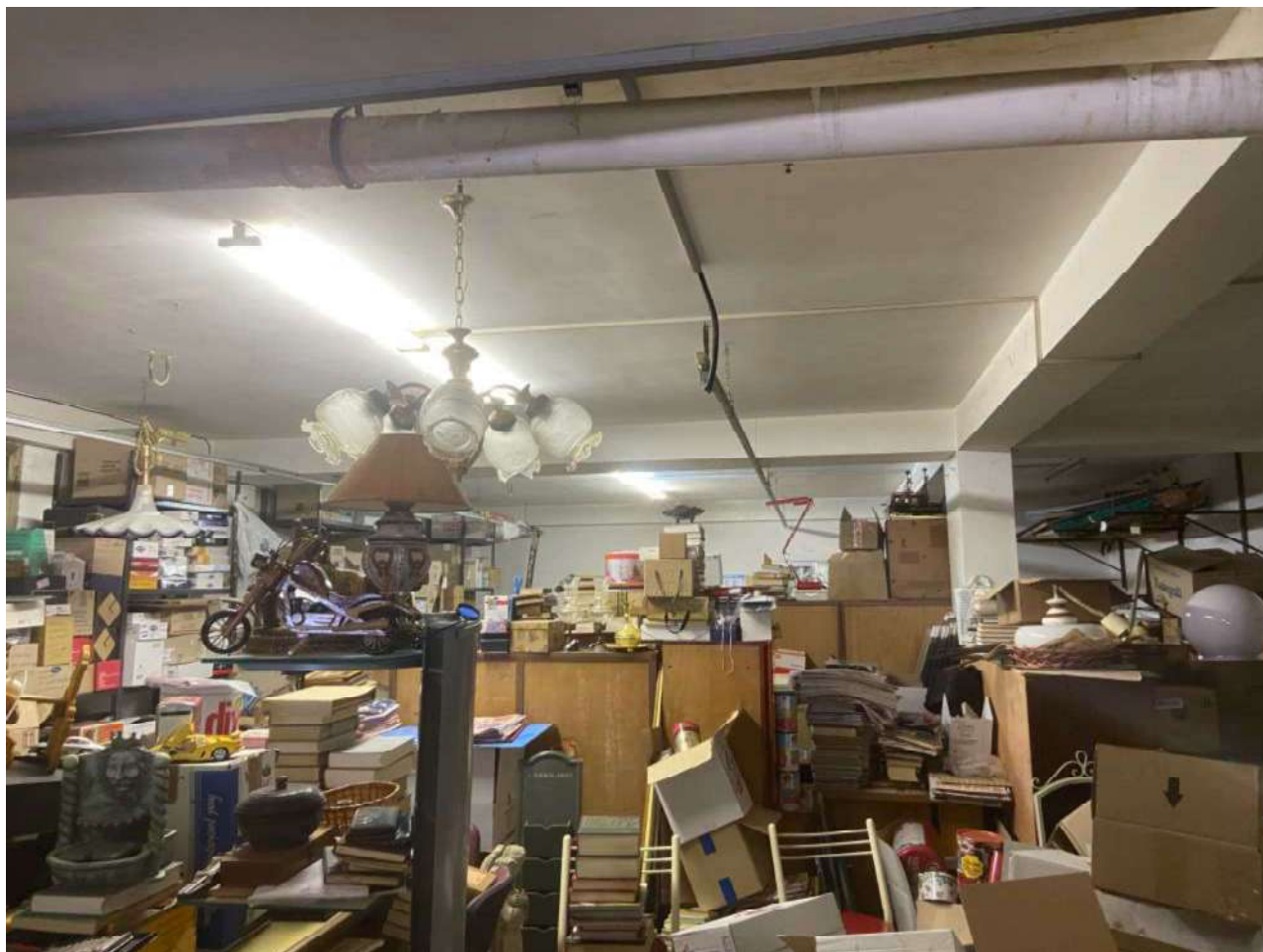
IMMAGINE 6: Locale deposito ubicato al piano seminterrato
