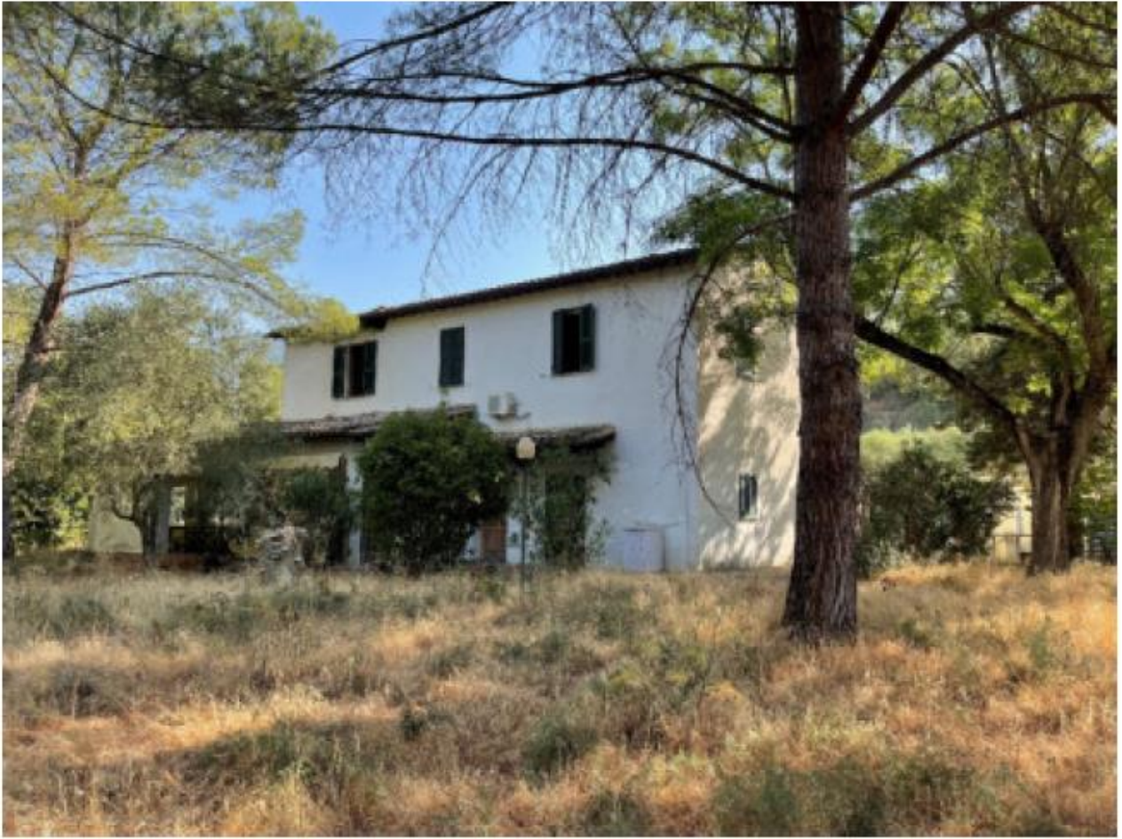
Foto n°10: prospetto del fabbricato n°1
