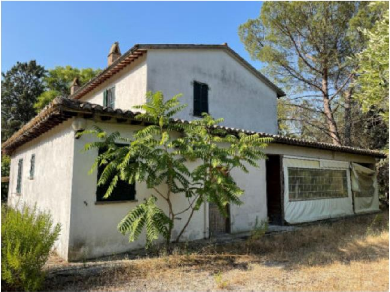
Foto n° 12: lato sx del fabbricato n° 1
