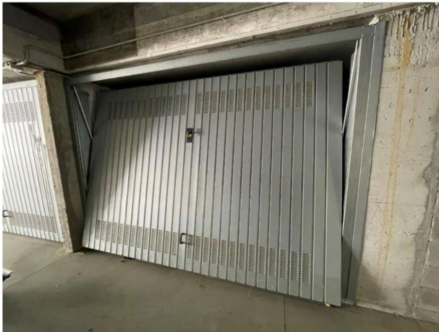
FOTO 8 – esterno autorimessa - RIPRESA FOTOGRAFICA EFFETTUATA DAL C.T.U.
