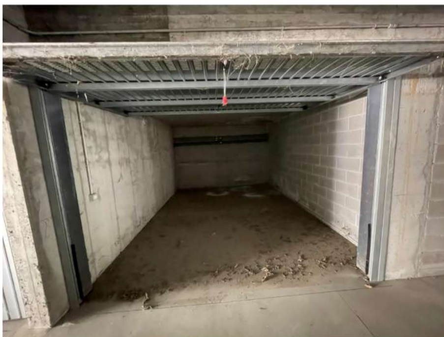
FOTO 9 – interno autorimessa - RIPRESA FOTOGRAFICA EFFETTUATA DAL C.T.U.
