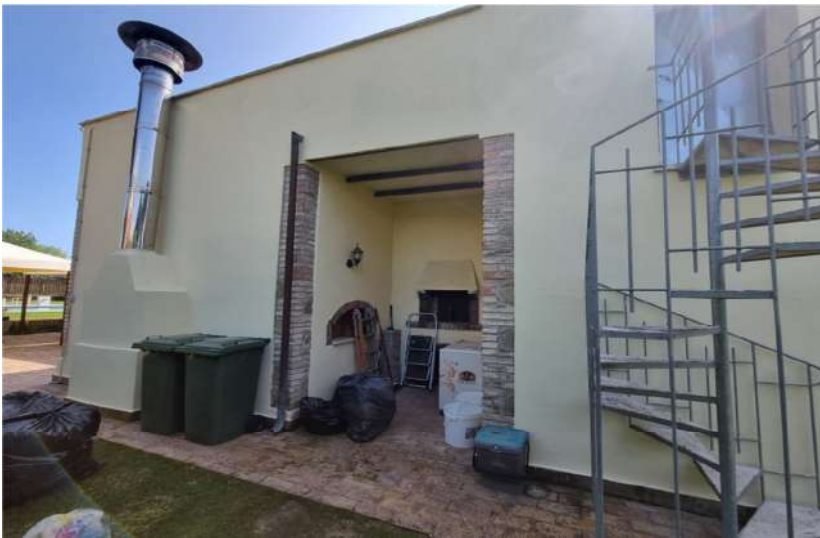
Accesso a locale di servizio al piano superiore
