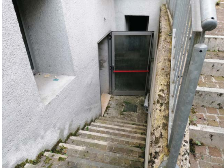
Accesso da Nord
