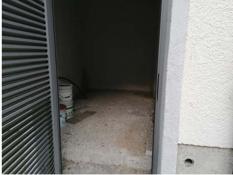
Vano Centrale Termica
