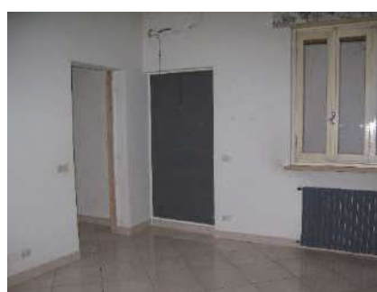
Foto 8 – Interno – Camera (P1)
