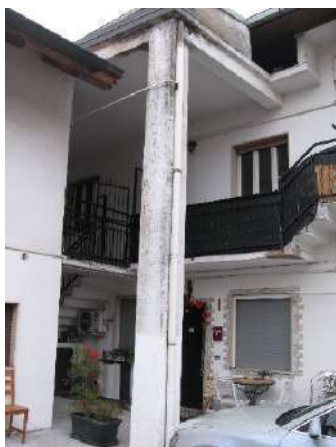
Foto 3 – Esterno – Fronte sud e scala esterna comune
