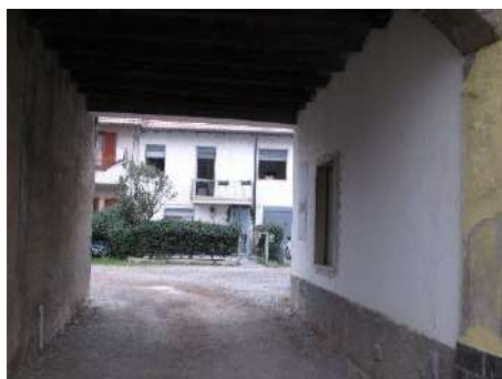
Foto 1 – Esterno – Vista da Vicolo Monti ingresso a corte comune
