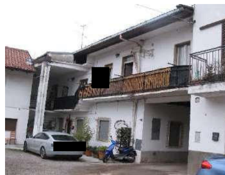
Foto 2 – Esterno – Vista da corte comune Fronte sud
