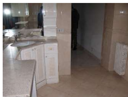
Foto 14 – Interno – Bagno (P1)
