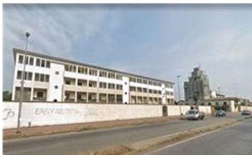
Particolare esterno edificio
