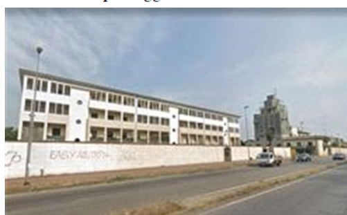
Particolare esterno edificio
