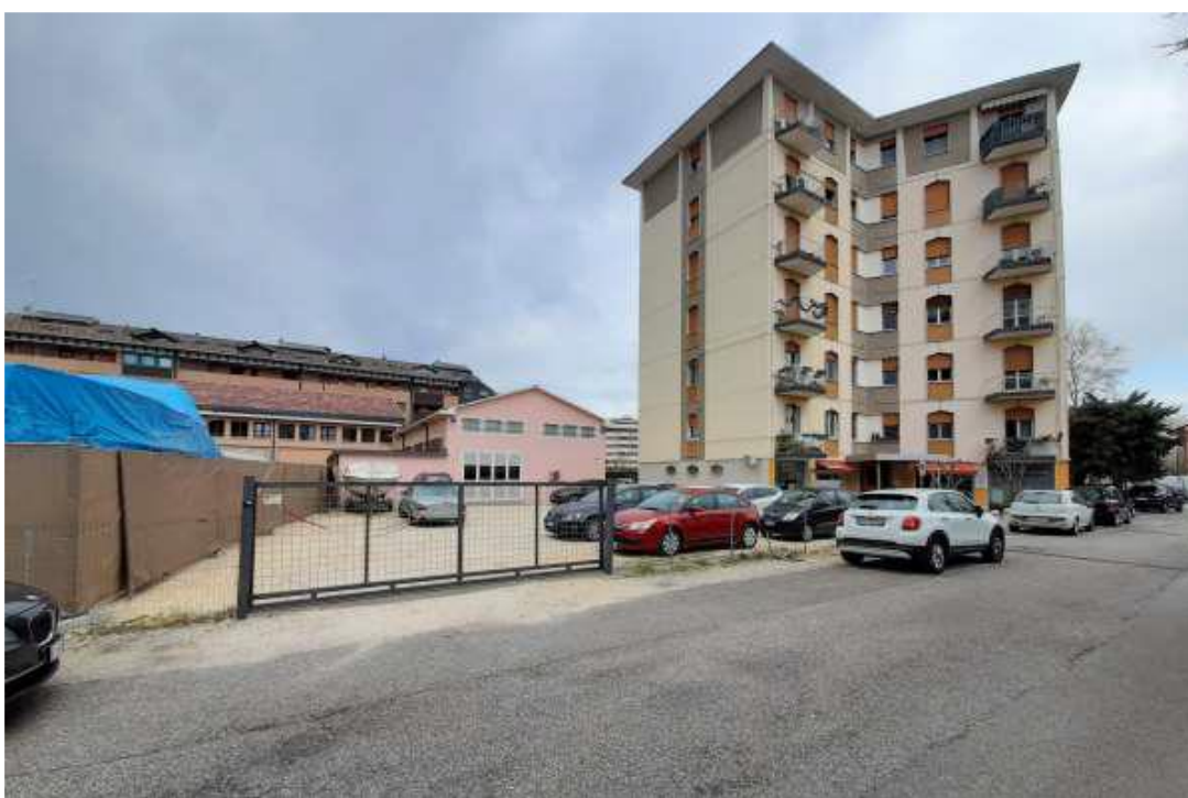
Vista generale degli esterni
