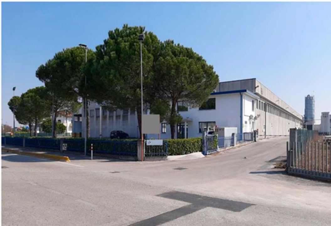
Vista generale degli esterni
