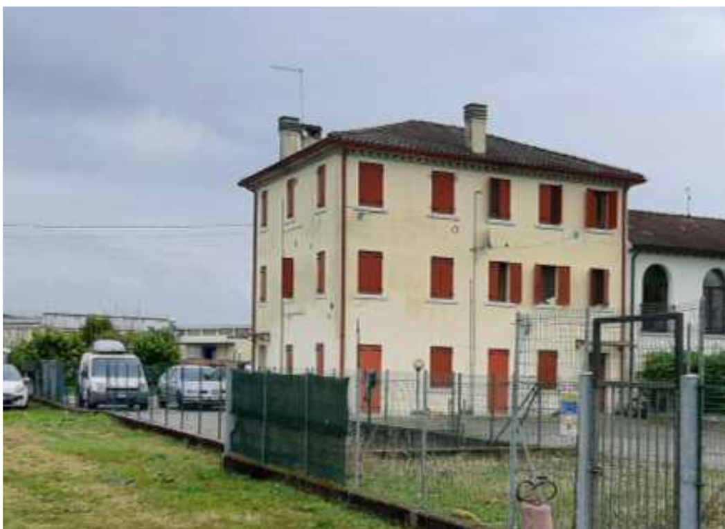
Vista generale degli esterni
