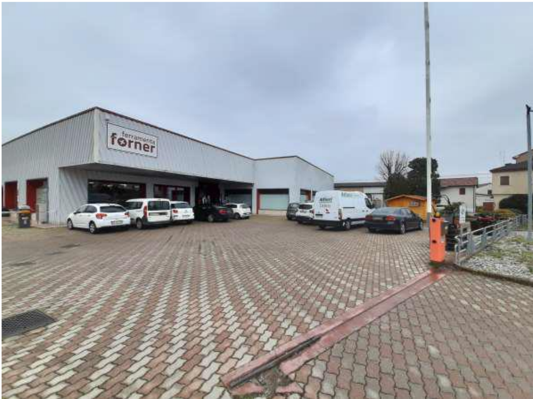
Vista generale degli esterni
