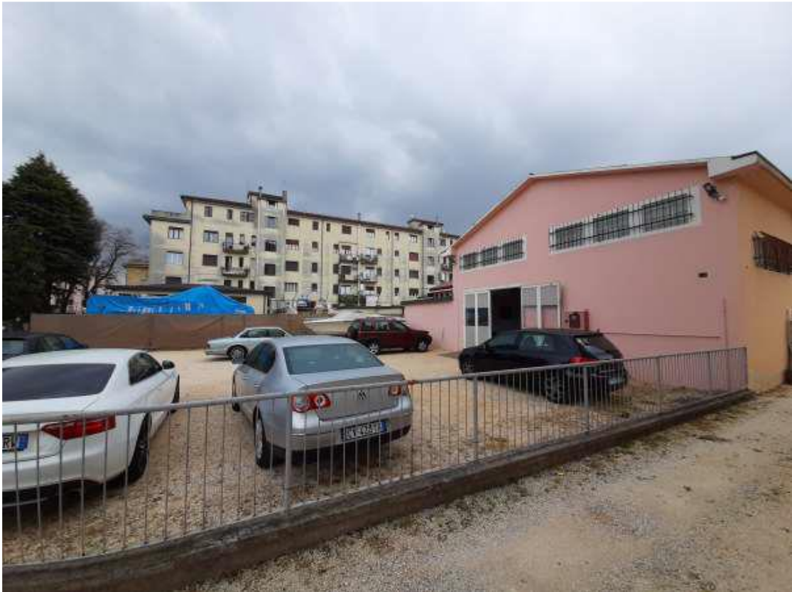
Vista generale degli esterni
