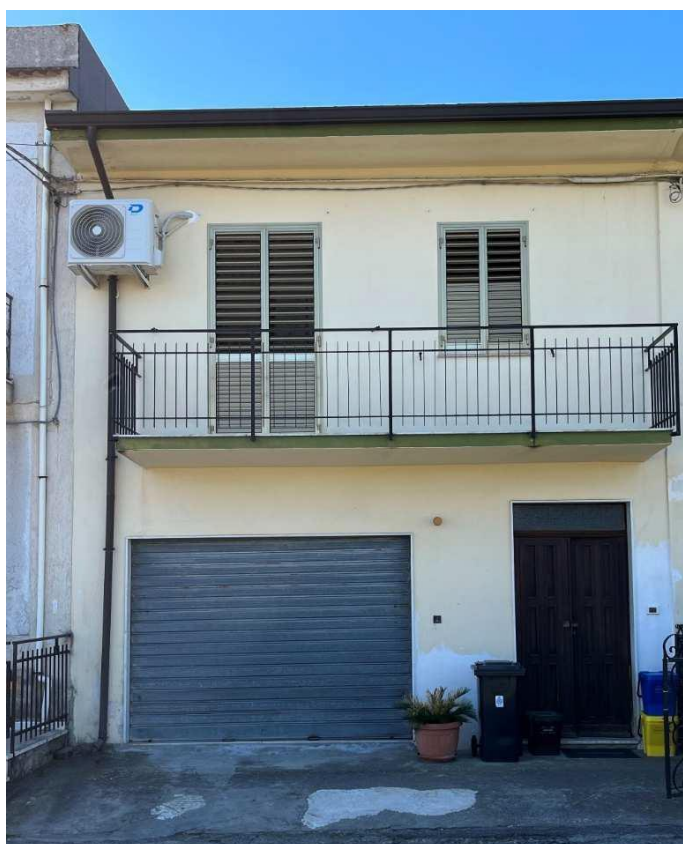
FOTO 13. Prospetto immobile particella 241 foglio 35
