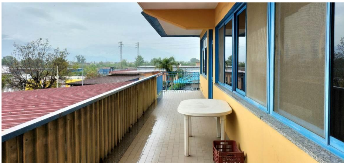
Palazzina Uffici – piano primo
