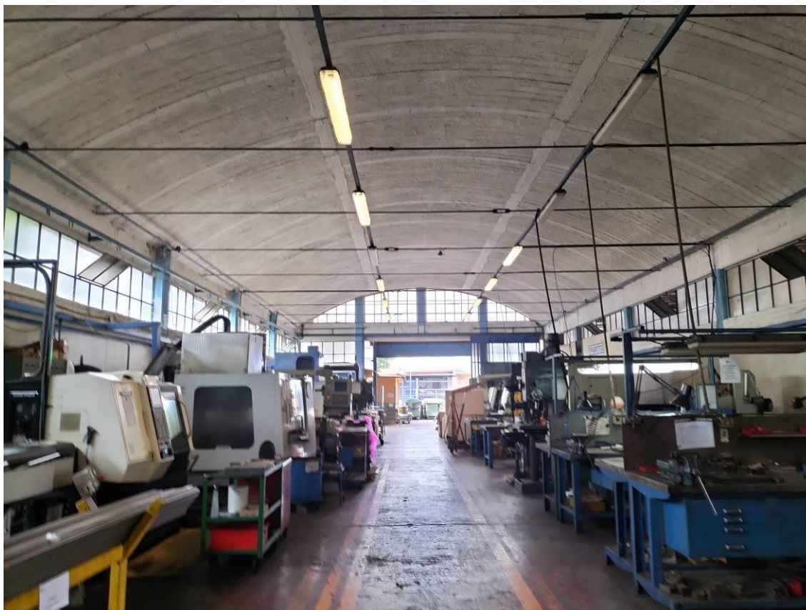
Capannone con volta a botte
