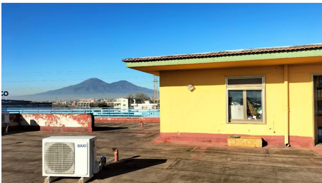
Archivio – lastrico solare
