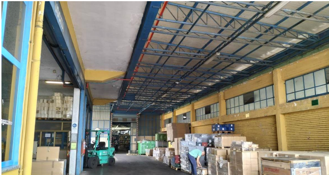
Piazzale coperto – tettoia
