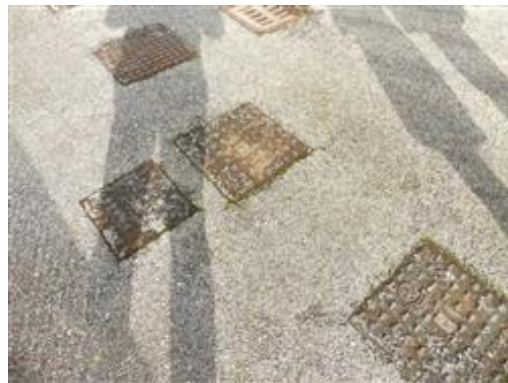
lato Ovest pozzetti fognari
