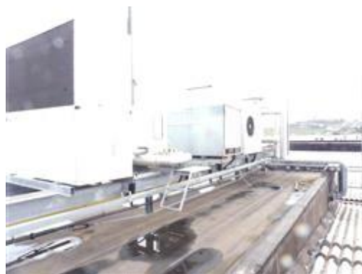
copertura e impianti
