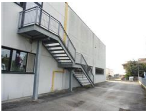
accesso esterno al piano primo sub. 6
