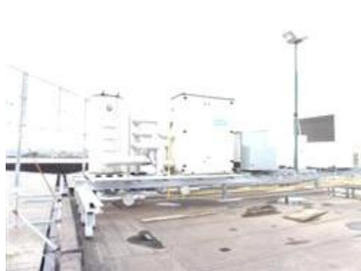
copertura e impianti
