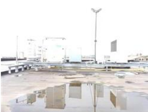
copertura e impianti
