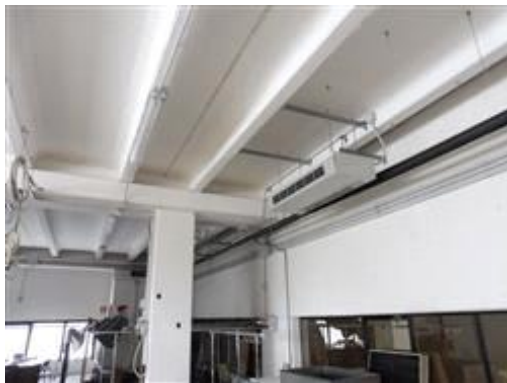
impianti parzialmente completati
