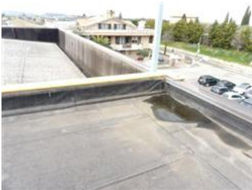
copertura e impianti
