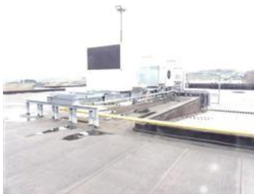
copertura e impianti
