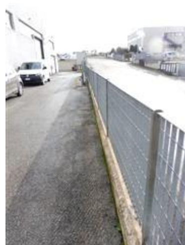
facciata lato Ovest
