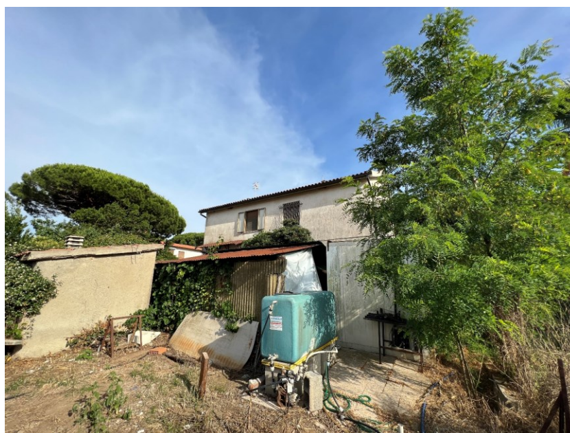
Vista 8: vista della tettoia in acciaio e lamiera e del L.T. / Forno dall'angolo della corte posteriore
