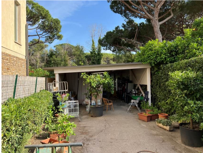
Vista 3: tettoia vista dall'appartamento
