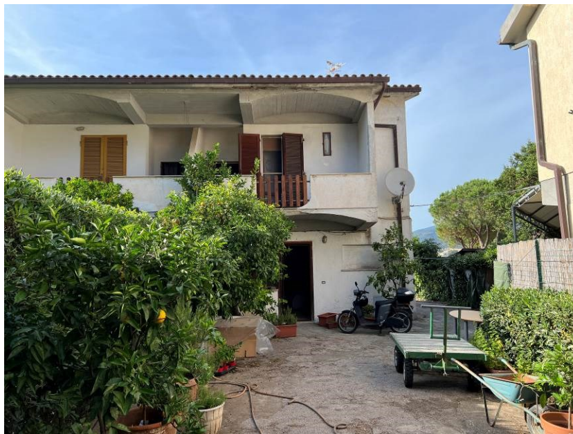
Vista 4: prospetto principale del fabbricato
