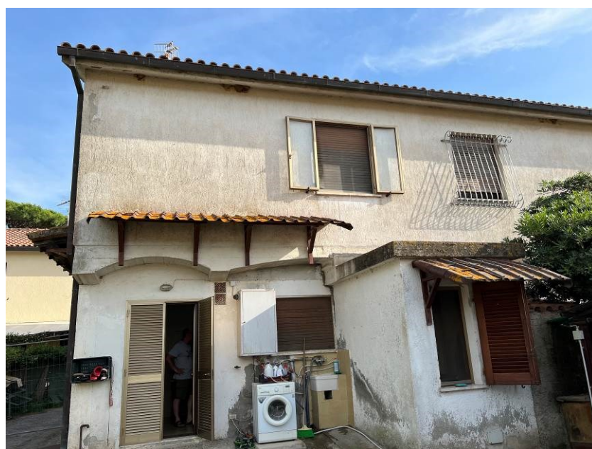
Vista 6: prospetto posteriore
