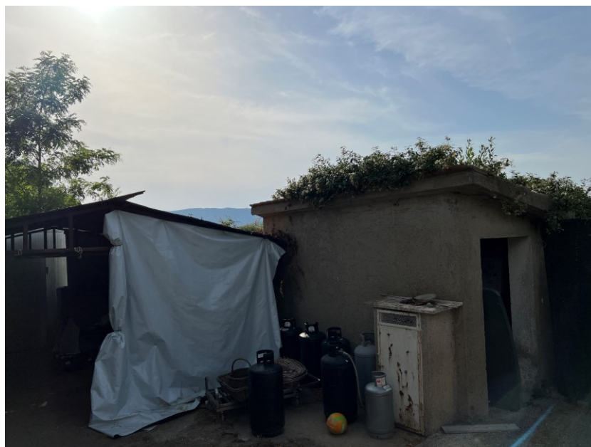
Vista 7: vista L.T / Forno e tettoia in acciaio e lamiera nella corte posteriore
