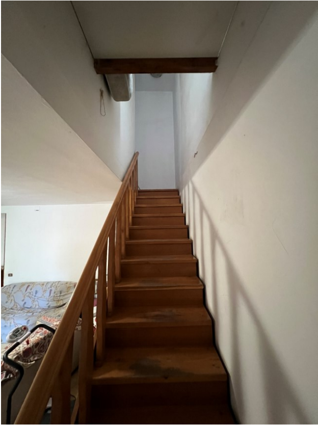
Vista 13: scala di collegamento interna
