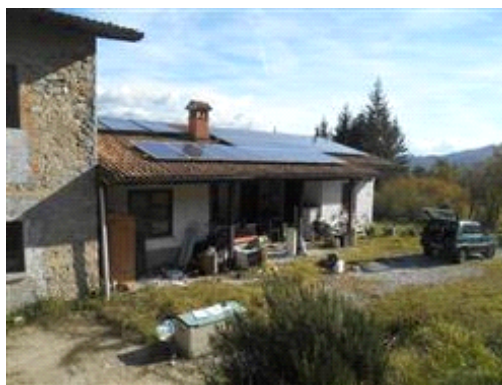
veduta del porticato nella parte centrale del fabbricato, con i sovrastanti pannelli degli impianti fotovoltaico e di produzione acqua calda sanitaria
