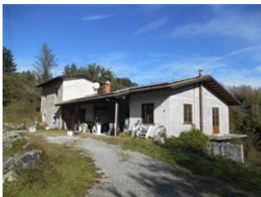
veduta della parte sud est del fabbricato oggetto di stima (il terreno circostante non è interessato dal pignoramento)
