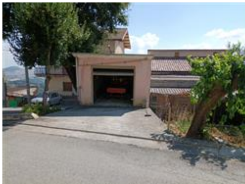
Vista esterna del garage/rimessa
