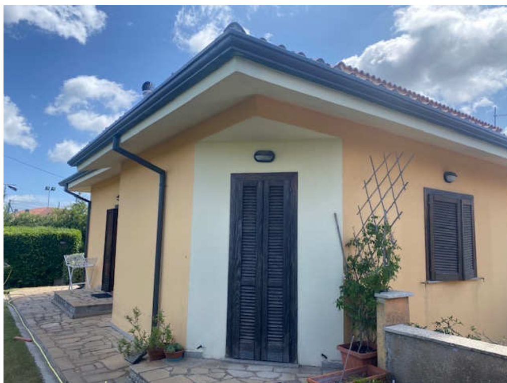
Foto 6 – Vista facciata secondaria – Ubicazione immobile
