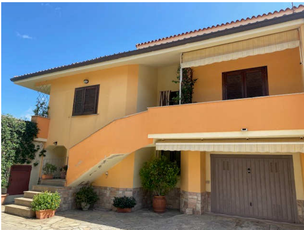
Foto 5 – Vista facciata principale – Ubicazione immobile
