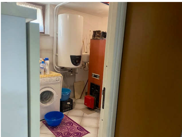
Foto 11 – Vista locale lavanderia
