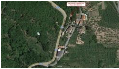
Vista satellitare con individuazione del fabbricato p.lla 4015
