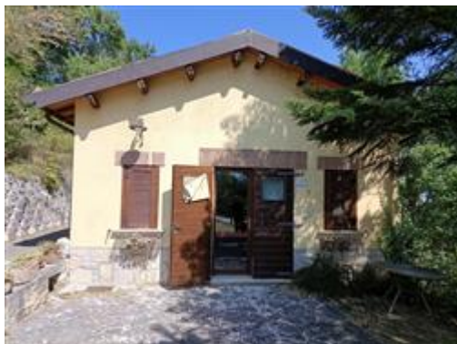
Vista esterna del fabbricato p.lla 4015
