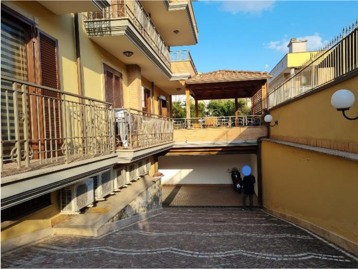
Rampa di accesso al piano seminterrato
