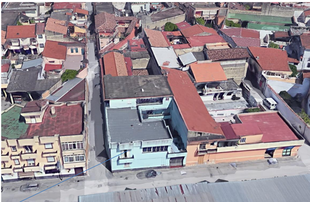
Fabbricato sito in San Marcellino, come era prima della demolizione e ricostruzione
