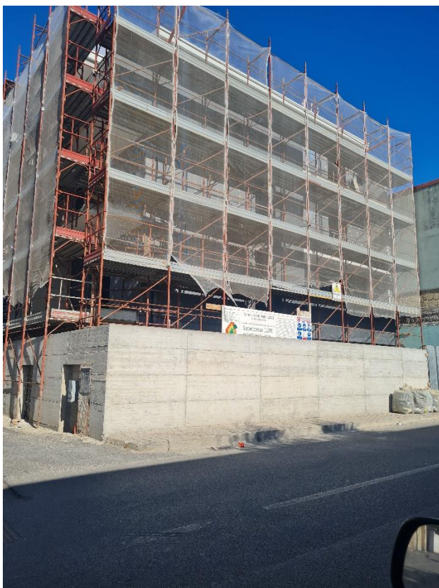
Fabbricato sito in San Marcellino, in corso di ricostruzione
