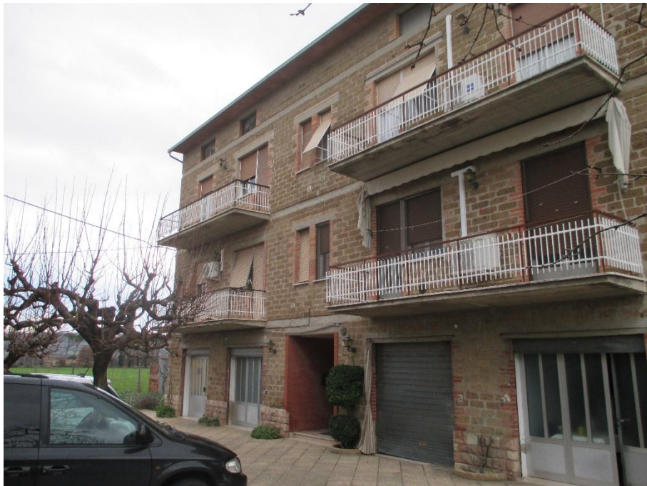
Foto n. 2b: Veduta dell'ingresso alle scale condominiali sul lato sud dell'edificio. Sulla sinistra al piano primo è visibile il terrazzo accessibile dal salotto-pranzo.
