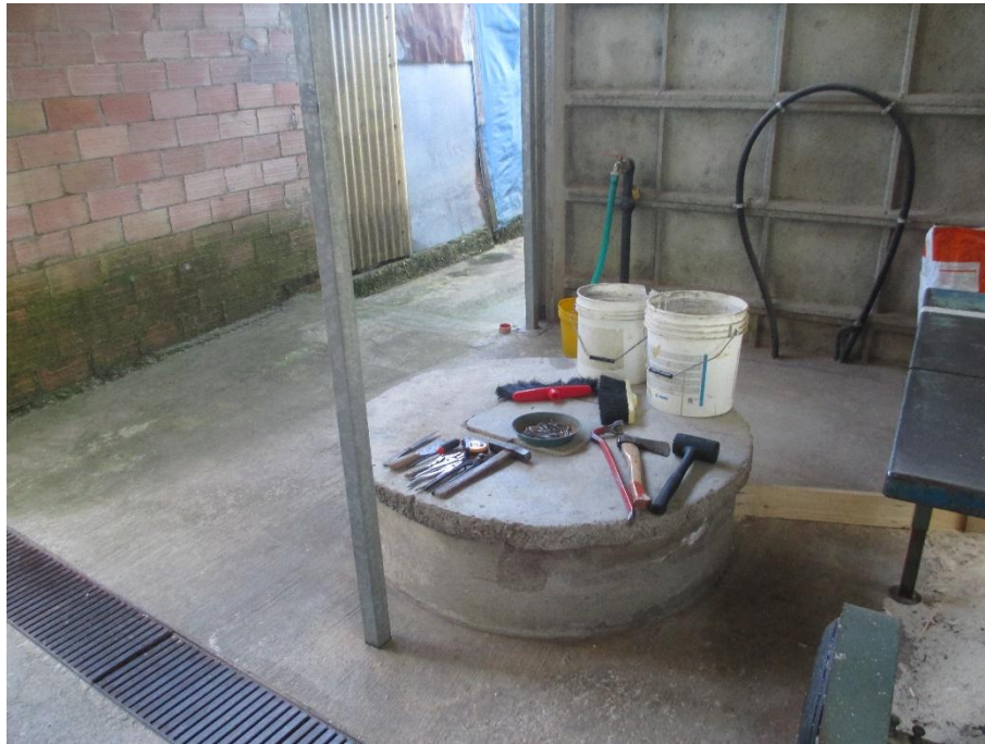
Foto n.5b: Particolare del pozzo comune a tutte le unità immobiliari, posto in prossimità dei fondi sul lato ovest dell'edificio.
