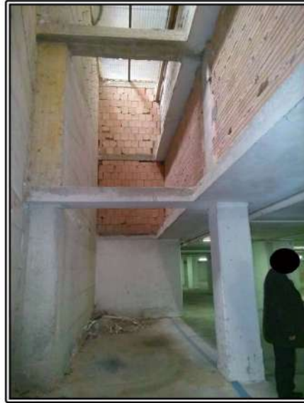
Figura 39 porzione della griglia - foto scattata da livello S4
