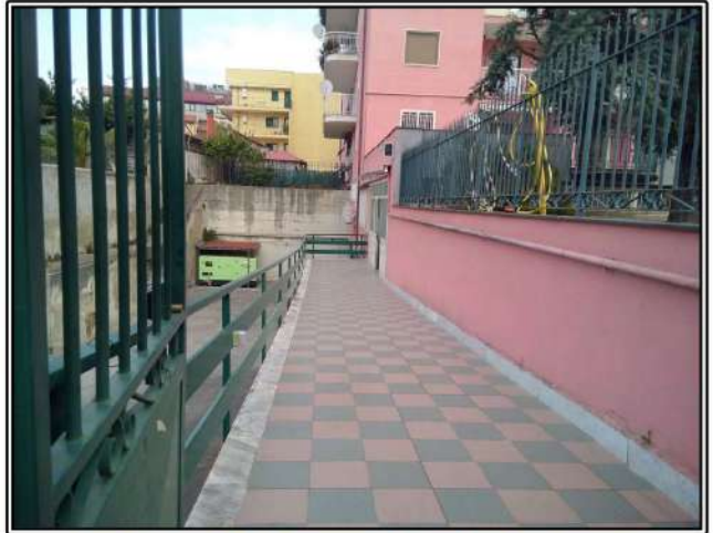
Figura 18 rampa di accesso al piano primo interrato
