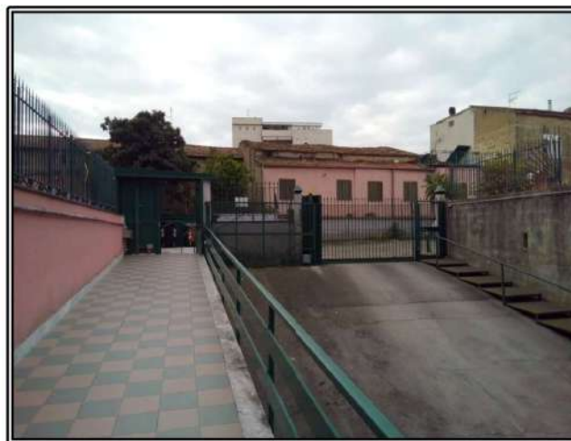
Figura 37 rampa carrabile da via San Nicola
