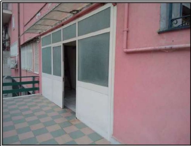
Figura 19 ingresso piano primo interrato
