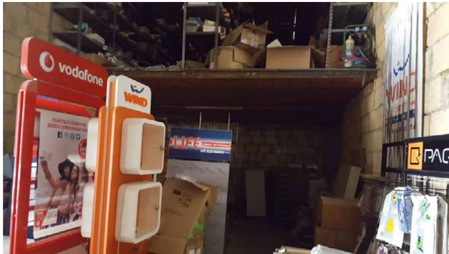
Foto N. 35: Interno del magazzino e controsoffitto Lotto L4
