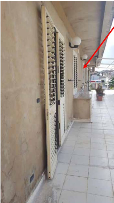
Foto N. 13: Vista Del Prospetto dal Terrazzo- Lotto L2
