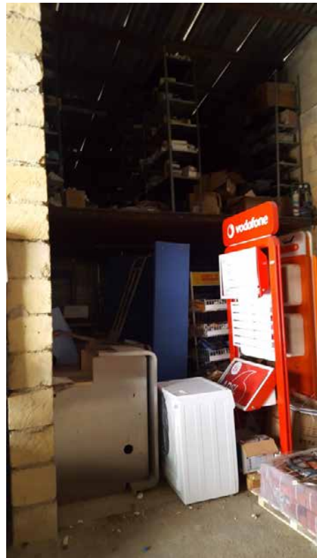
Foto N. 21: Interno del magazzino e controsoffitto Lotto L4
