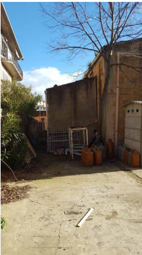
Foto N. 3: Locale Idrico da demolire Lotto L4
