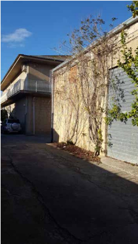
Foto N. 12: Vista Posteriore piano terra Lotto L1 dalla Corte del Lotto L4
