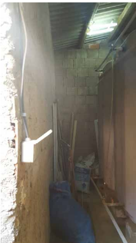
Foto N. 7: Locale idrico da demolire Lotto L4
