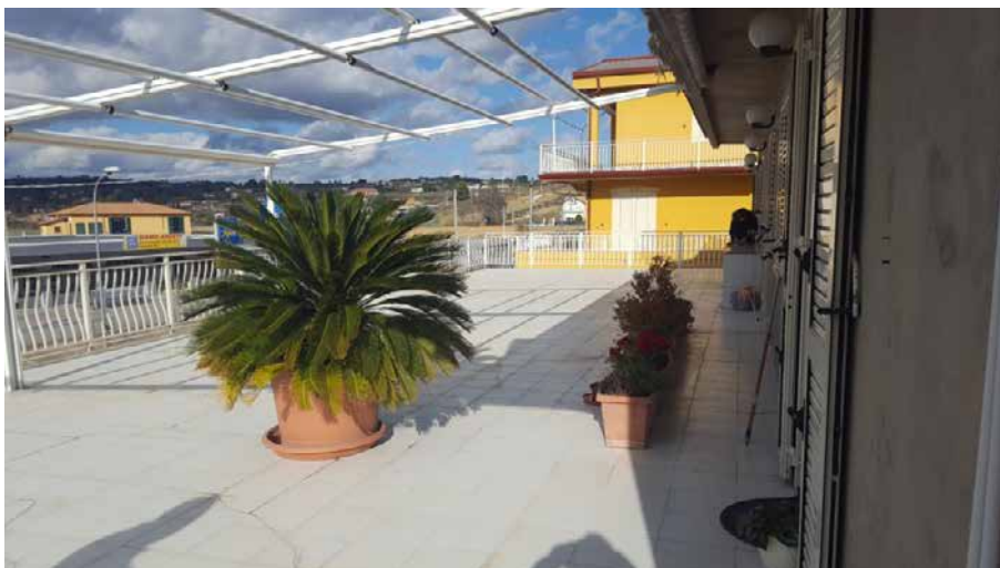
Foto N. 12: Vista Del Terrazzo- Lotto L2
