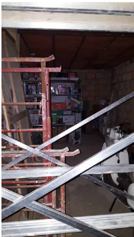
Foto N. 32: Interno del magazzino e controsoffitto Lotto L4
