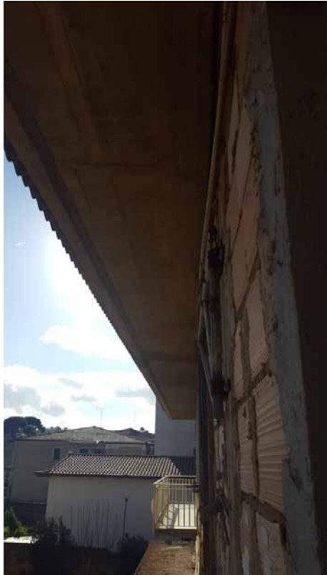
Foto N. 10: Vista Del Balcone Posteriore- Lotto L3
