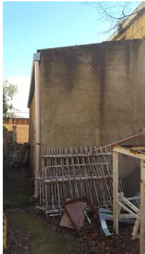
Foto N. 2: Locale Idrico da demolire Lotto L4
