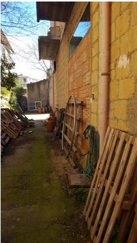
Foto N. 11: Locale idrico da demolire visto dalla corte interna dei lotti L1-L2-L3-Lotto L4
