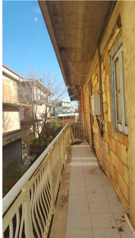
Foto N. 11: Vista Del Balcone Posteriore- Lotto L3
