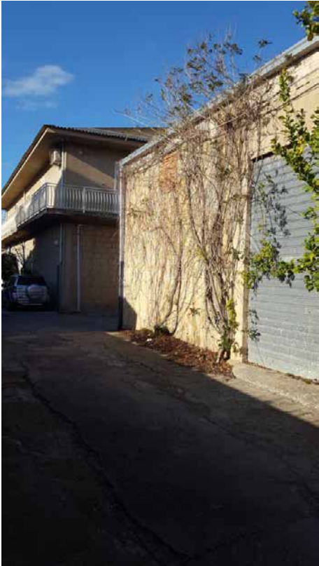
Foto N. 9: Ingresso laterale visto dalla corte Interna da murare lotto L4
