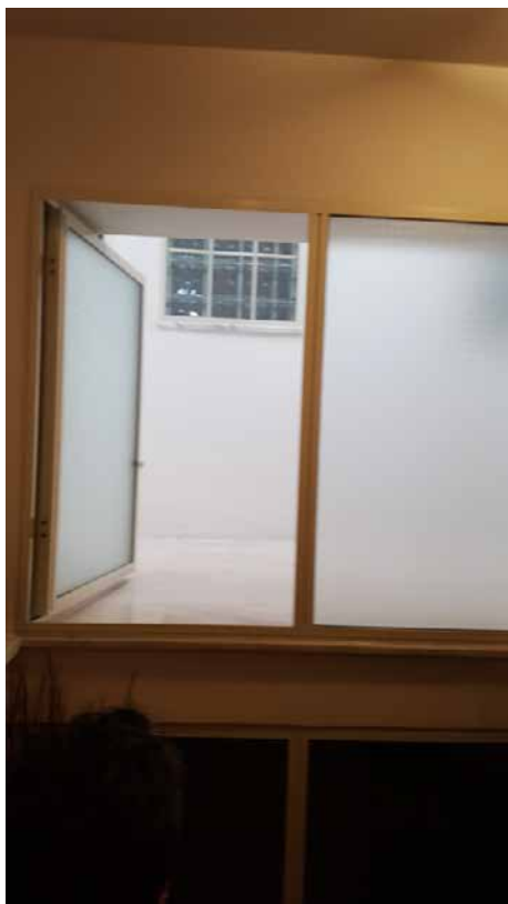
Foto N. 16: Accesso pozzo luce del Lotto L2 dalla scala comune ai Lotti L2-L3
