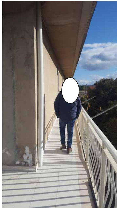
Foto N. 14: Vista Balcone - Lotto L2
