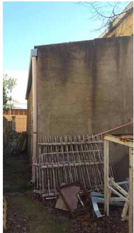
Foto N. 12: Locale Idrico da demolire Lotto L4
