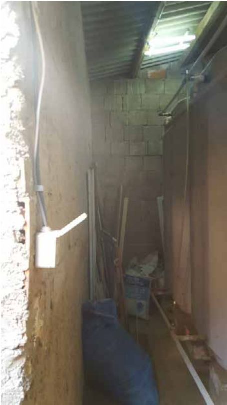
Foto N. 16: Locale idrico da demolire Lotto L4
