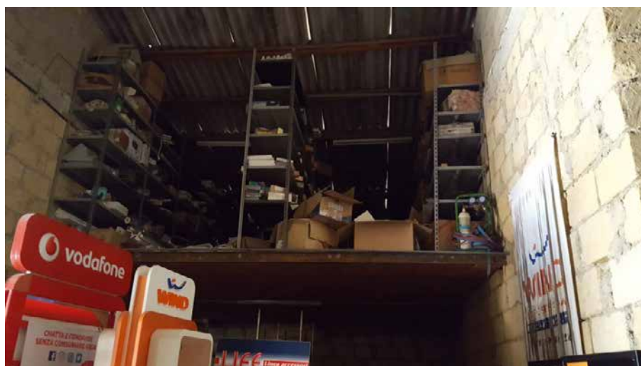
Foto N. 34: Interno del magazzino e controsoffitto Lotto L4
