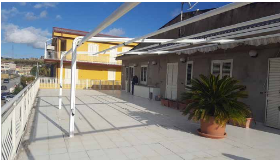
Foto N. 11: Vista Del Terrazzo- Lotto L2
