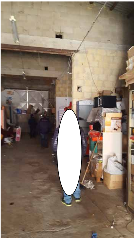
Foto N. 18: Interno del magazzino Lotto L4
