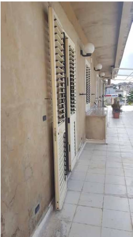
Foto N. 8: Vista Del Prospetto dal Terrazzo- Lotto L3
