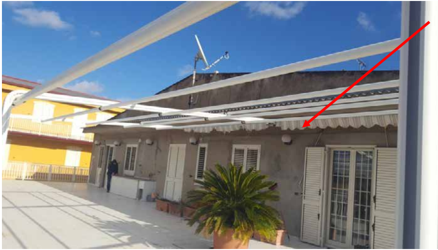
Foto N. 10: Vista Del Terrazzo- Lotto L2
