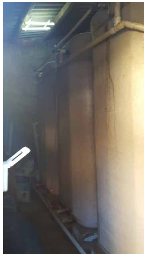
Foto N. 4 : Vasche Idriche all'interno del locale idrico da demolire Lotto L4
