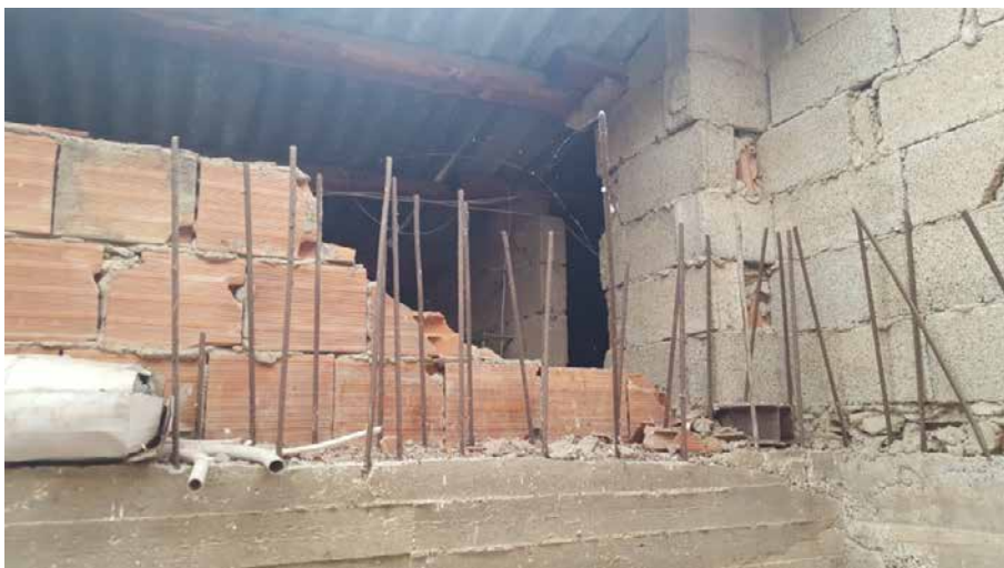
Foto N. 31: Sottotetto. Lotto L3
