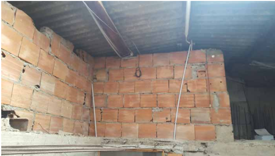
Foto N. 29: Sottotetto. Lotto L3
