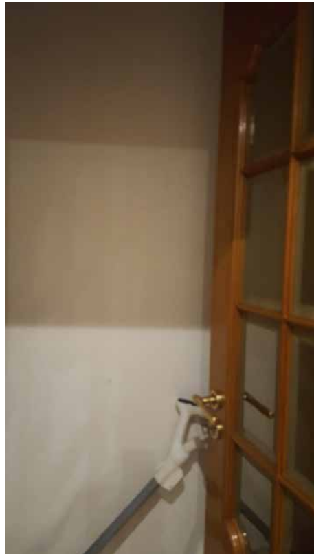
Foto N. 29: finitura della porta del ripostiglio 1 Lotto L2
