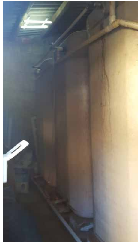
Foto N. 14: Vasche Idriche all'interno del locale idrico da demolire Lotto L4
