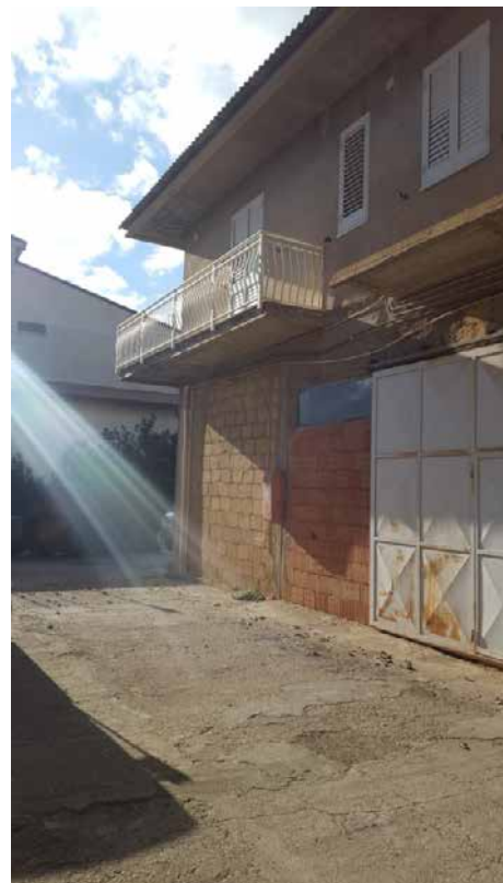
Foto N. 9: Vista Posteriore Dalla Corte Lotto L1-L2-L3
