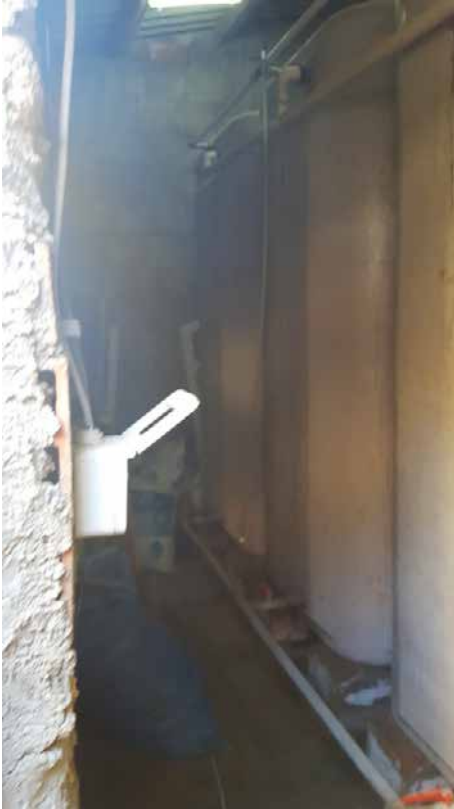
Foto N. 5: Vasche Idriche all'interno del locale idrico da demolire Lotto L4
