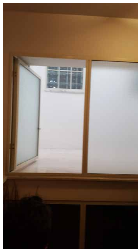
Foto N. 20: Accesso pozzo luce dalla scala comune al Lotto L2-L3 . Lotto L2
