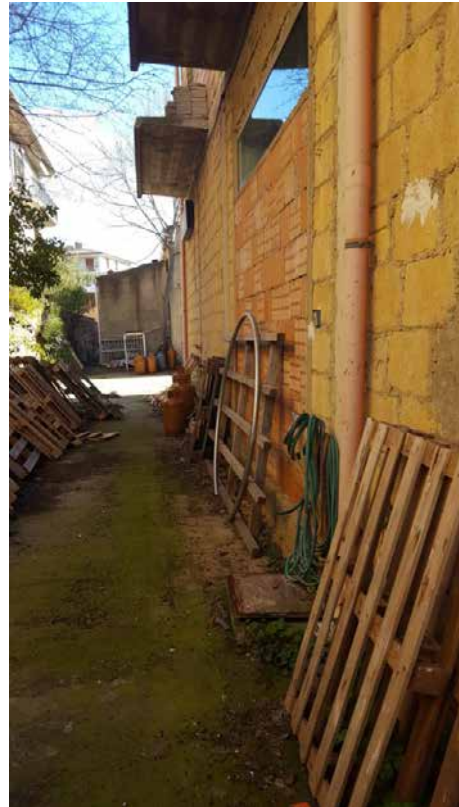
Foto N. 13: Vista laterale sinistra piano terra Lotto L1
