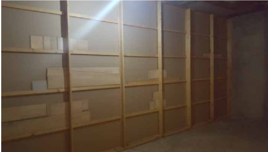
Foto N. 23: Parete divisoria tra Vano 1 e Vano n. 2. Piano Primo Lotto L3
