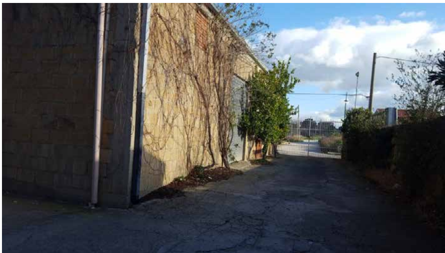
Foto N. 3: cancello sinistro di accesso visto dalla corte interna Lotto L4
