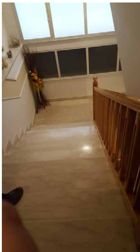
Foto N. 15: Scala D'ingresso comune ai lotti L2-L3 dal piano 1°. Lotto L3
