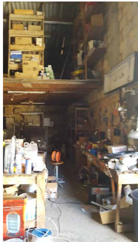
Foto N. 19: Interno del magazzino e controsoffitto Lotto L4
