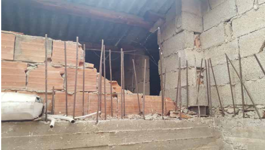
Foto N. 32: Sottotetto. Lotto L3
