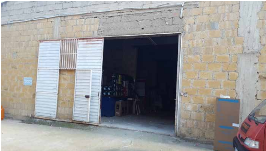
Foto N. 8: Ingresso dalla corte interna al lotto L4
