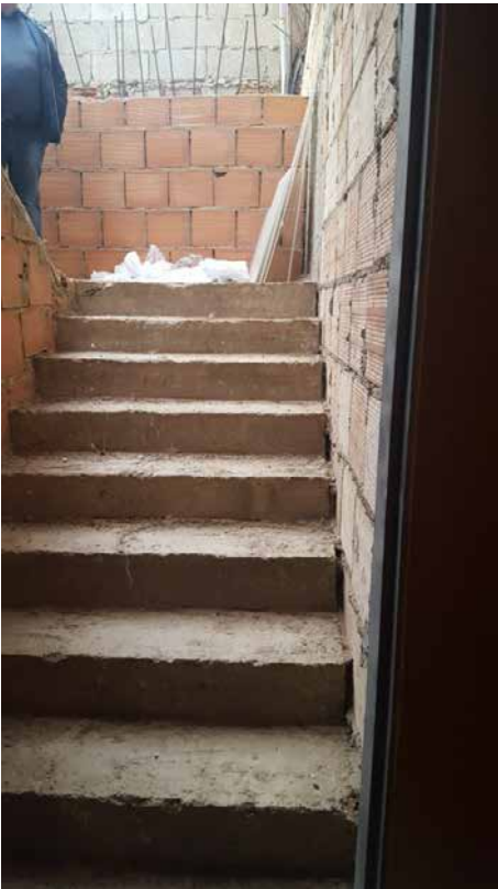
Foto N. 27: Scala di accesso al sottotetto dal Vano n. 2. Prima Rampa. Lotto L3
