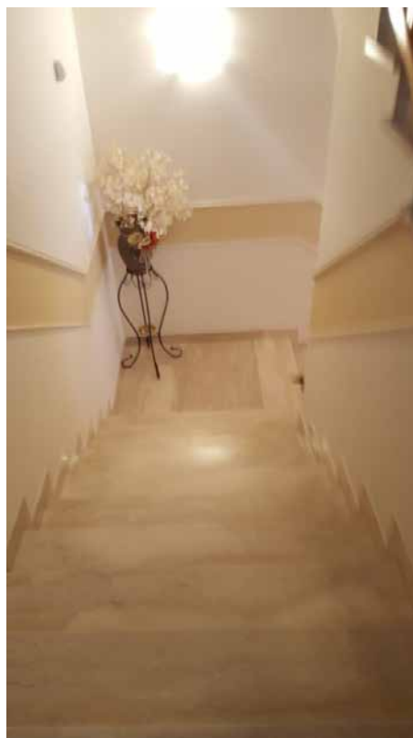
Foto N. 18: Scala D'ingresso 2° rampa scala comune Lotto L2-L3
