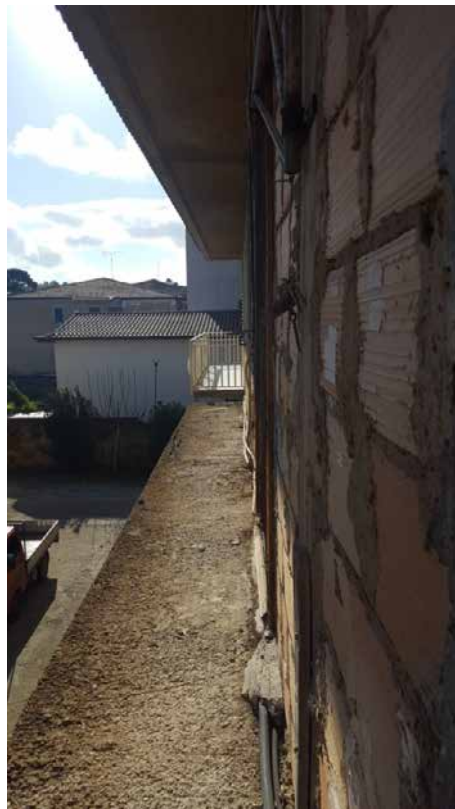
Foto N. 9: Vista Del Balcone Posteriore- Lotto L3
