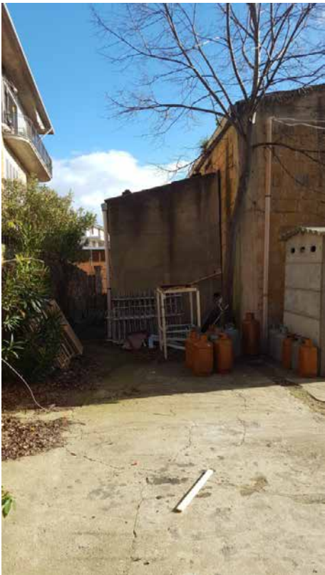
Foto N. 13: Locale Idrico da demolire Lotto L4
