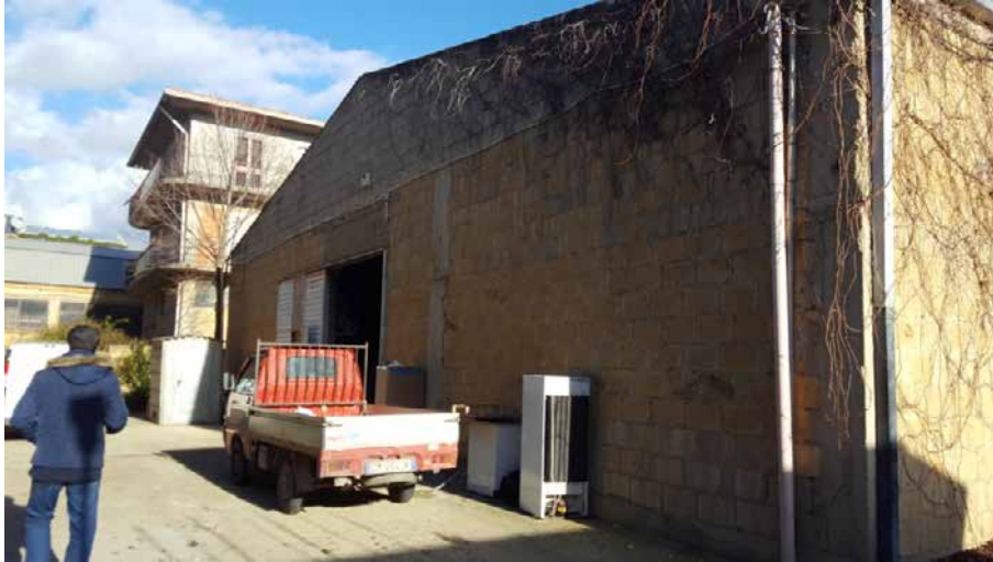
Foto N. 7: Prospetto posteriore visto dalla corte interna al lotto L4
