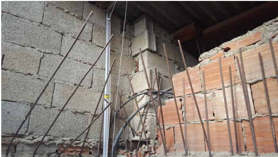
Foto N. 30: Sottotetto. Lotto L3
