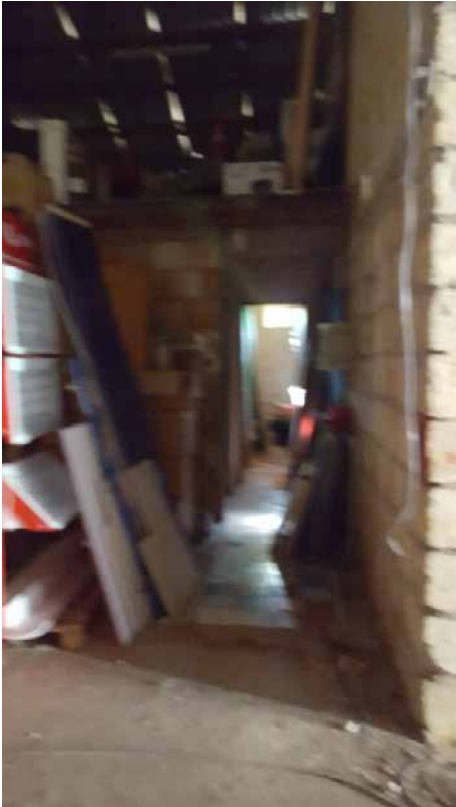
Foto N. 24: Interno del magazzino Lotto L4
