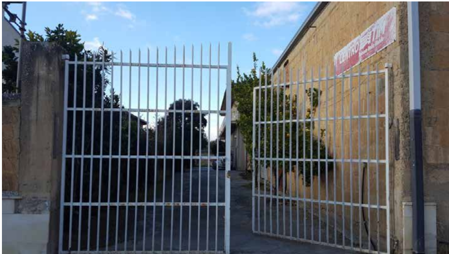
Foto N. 2: cancello sinistro di accesso dal Viale Delle Rose Lotto L4
