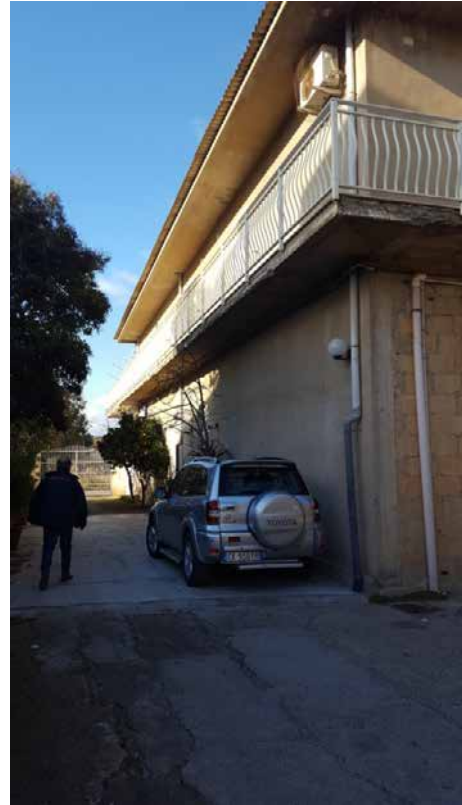
Foto N. 7: Vista Laterale piano terra lotto L1 dalla Corte dei Lotti L1-L2-L3
