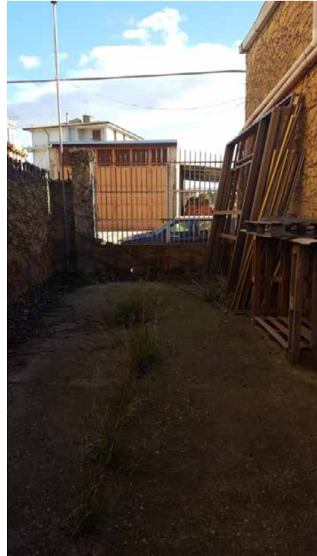
Foto N. 5: cancello sinistro di accesso visto dalla corte interna Lotto L4
