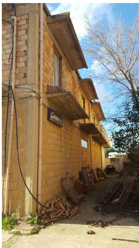
Foto N. 5: Vista Laterale Dalla Corte Comune ai lotti L1-L2-L3. Piano Primo Lotto L3
