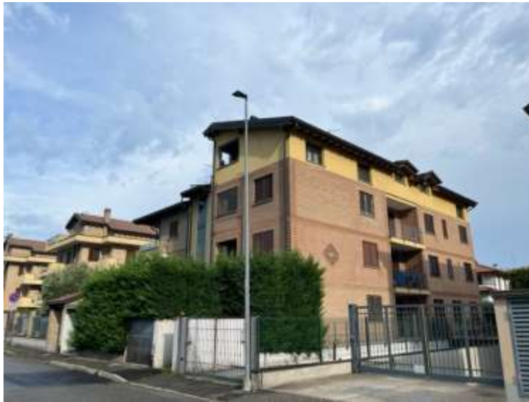
Foto n. 1 L'edificio dalla via Dei Mariani
