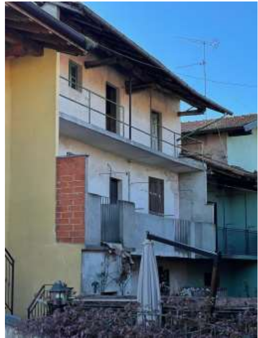
Foto 3 – vista della proprietà verso la corte interna
