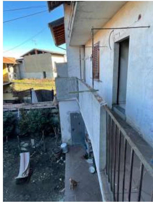
Foto 11 – scorcio della facciata interna e del locale caldaia
