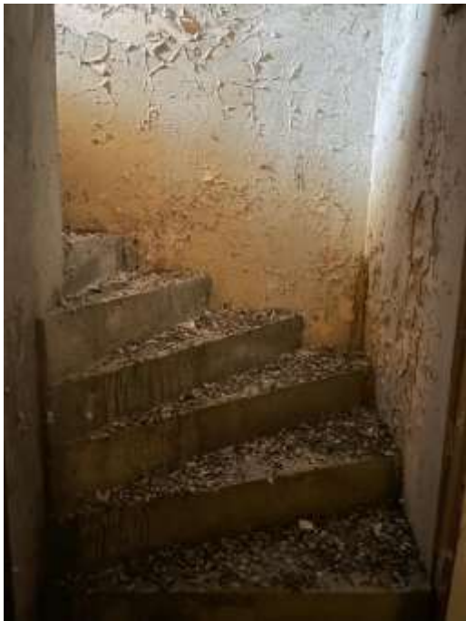
Foto 10 – scala di accesso al piano sottotetto
