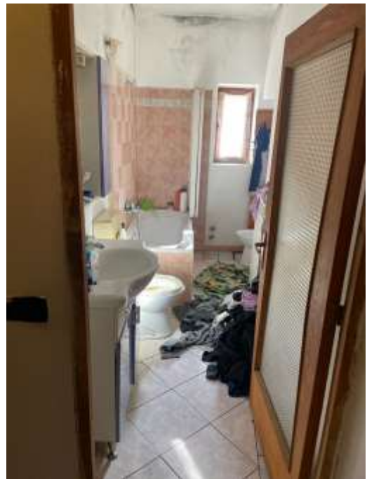
Foto 9 – bagno al primo piano
