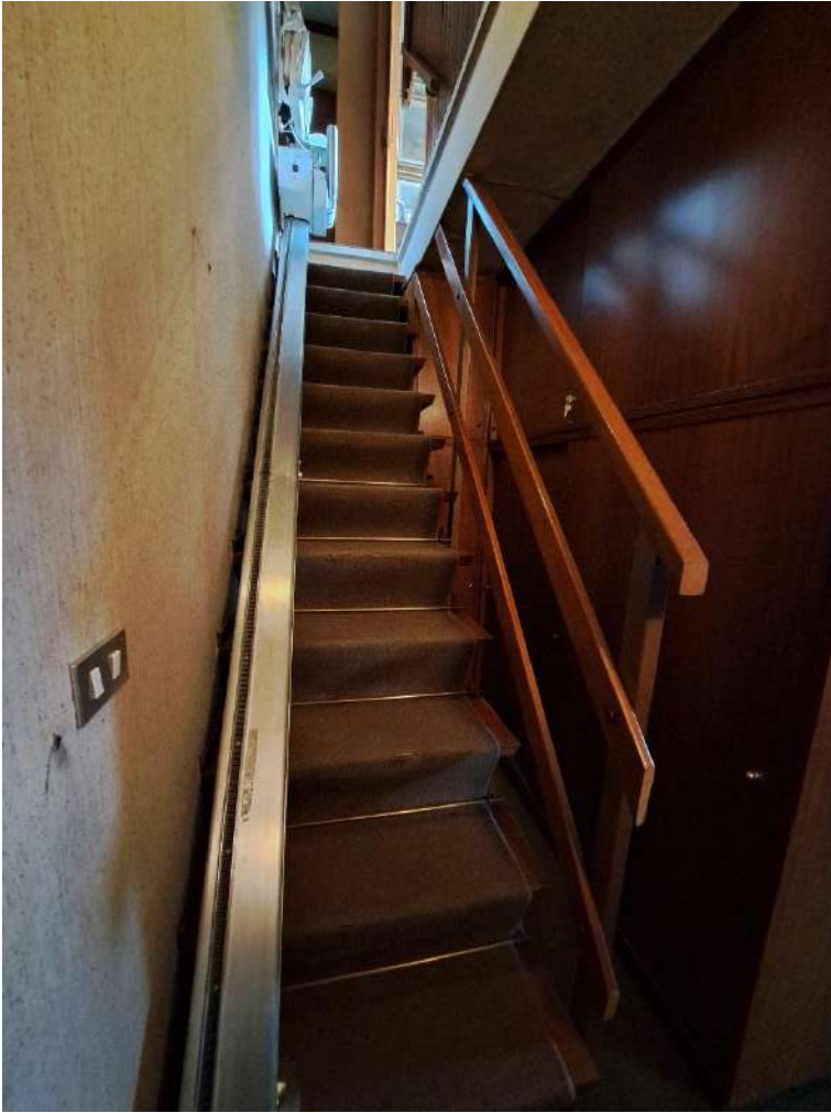
Scala collegamento piano terra - rialzato
