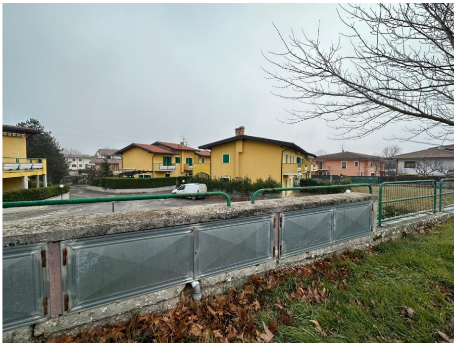
Foto n.1 – Vista dell'immobile da Via Stazione
