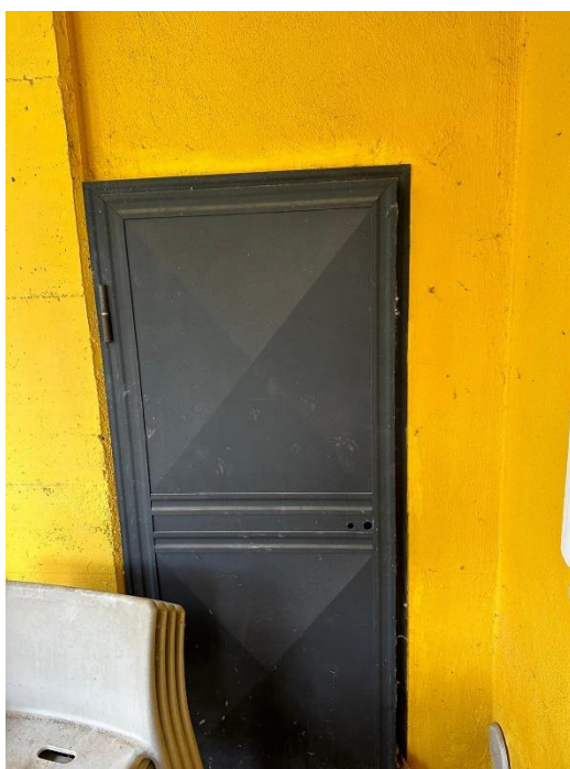
Foto n.12 – Magazzino con vista dalla corte esclusiva
