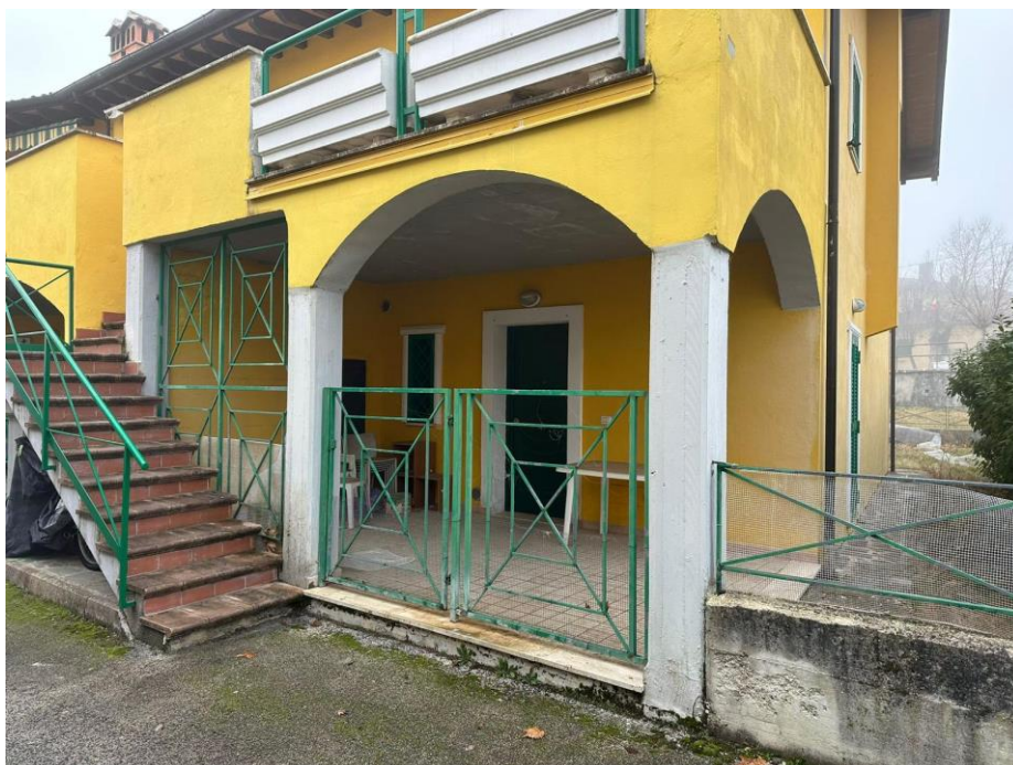
Foto n.3 – Vista frontale dell'immobile
