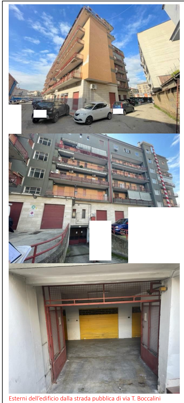
Esterni dell'edificio dalla strada pubblica di via T. Boccalini
