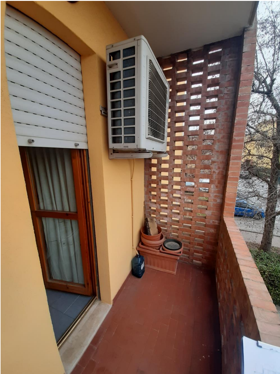
Foto n. 31 – terrazzo accessibile dal bagno
