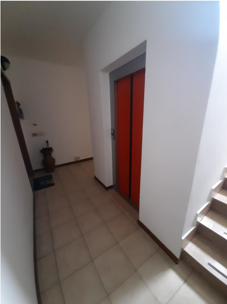
Foto n. 14 – Disimpegno comune con vista su vano ascensore
