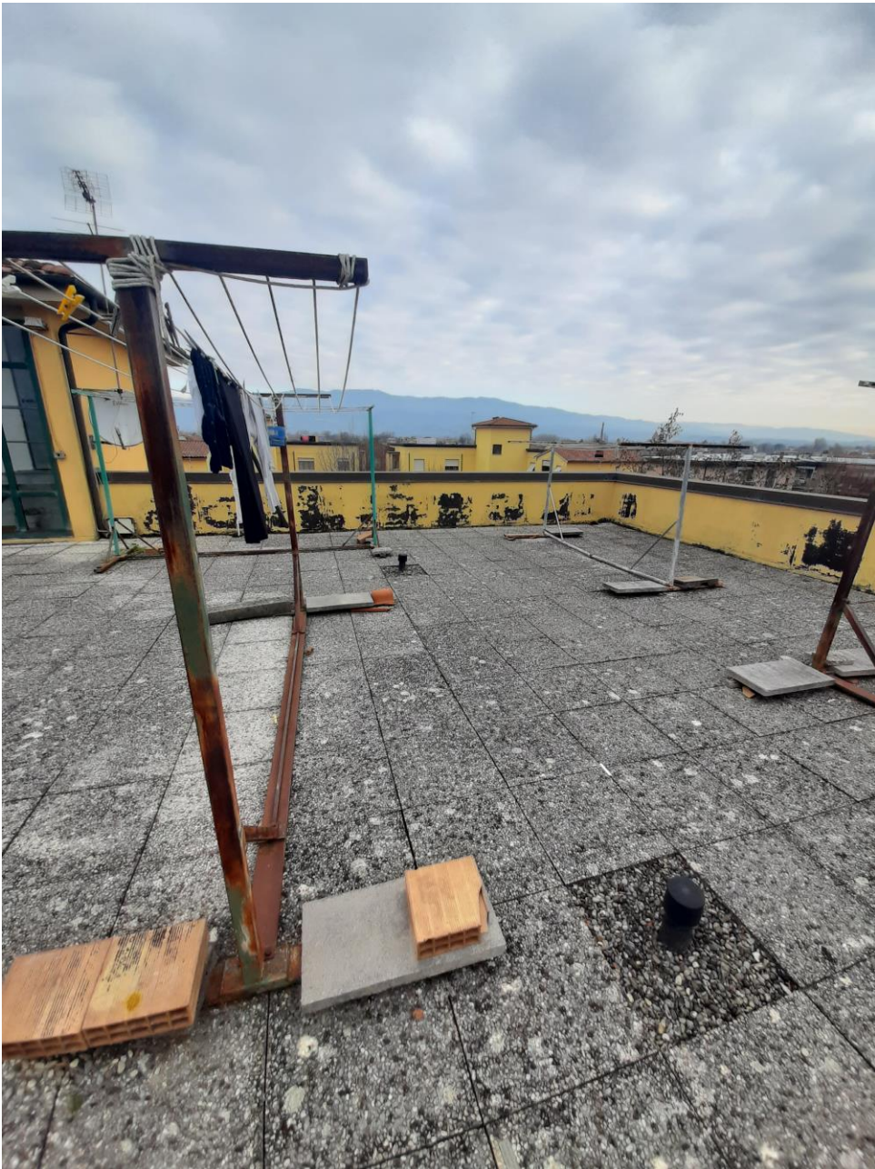
Foto n. 16 – Lastrico solare comune
