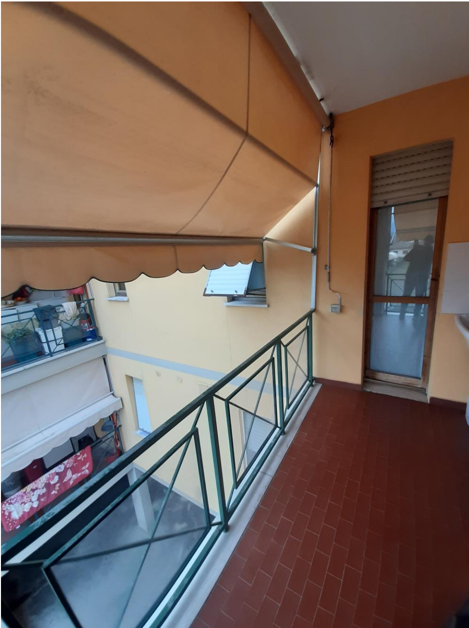
Foto n. 20 – terrazzo coperta accessibile dal soggiorno
