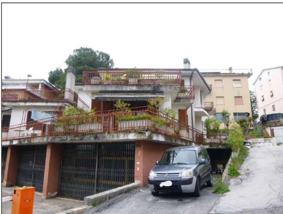
Foto 02 Vista dell'edificio da via D. Nobili – lato Sud-Ovest
