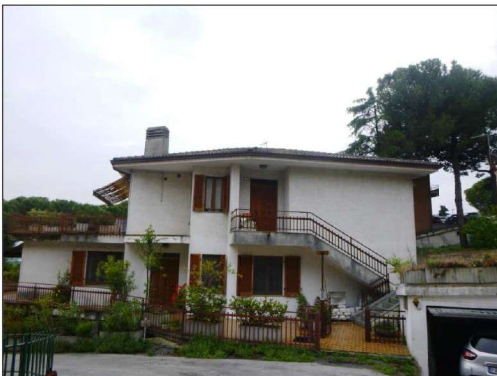
Foto 01 Vista dell'edificio da via D. Nobili – lato Nord-Est
