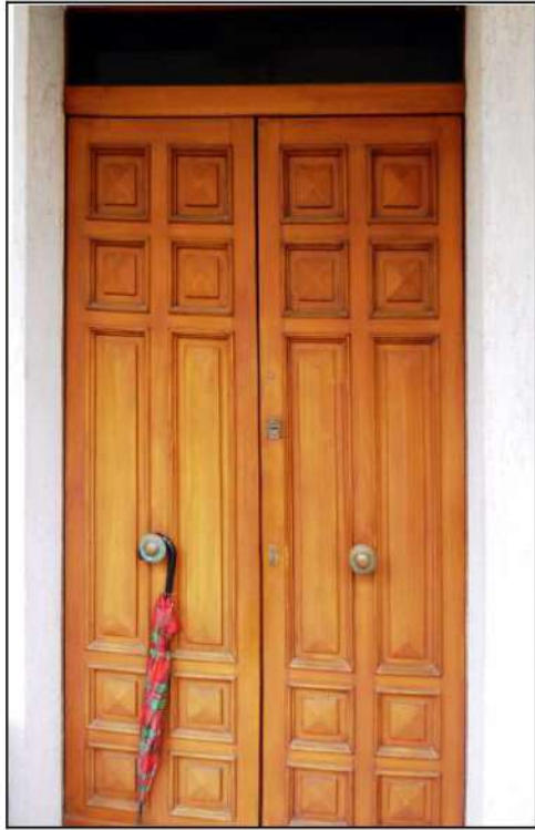
Foto 11 Vista dell'immobile – portone d'ingresso
