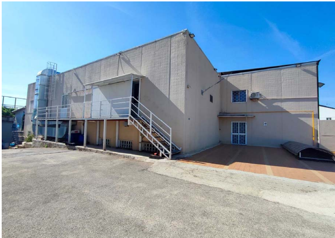
Foto 23. Porzione di Capannone e blocco Uffici (Sub.4)
