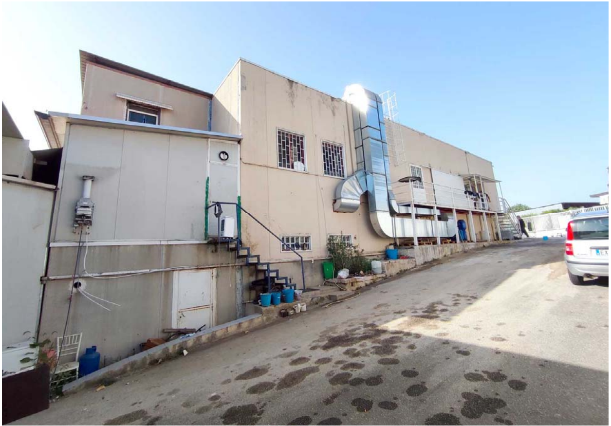
Foto 34. Immobile (Sub.4) visto dallo spazio esterno sub.2
