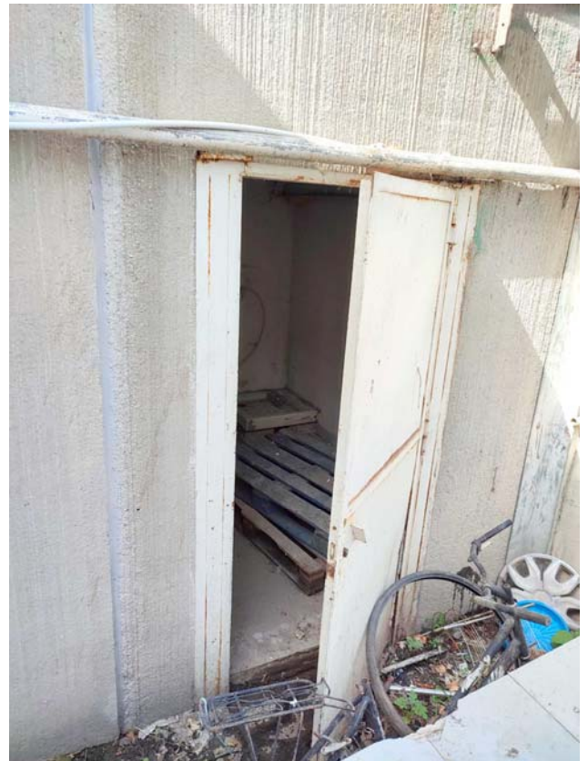
Foto 36. Ingresso al locale sub.6
