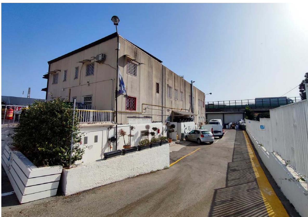
Foto 07. Vista del capannone dall'ingresso principale (piano seminterrato) e dello spazio esterno
