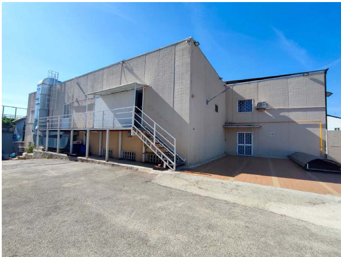
Foto 23. Porzione di Capannone e blocco Uffici
