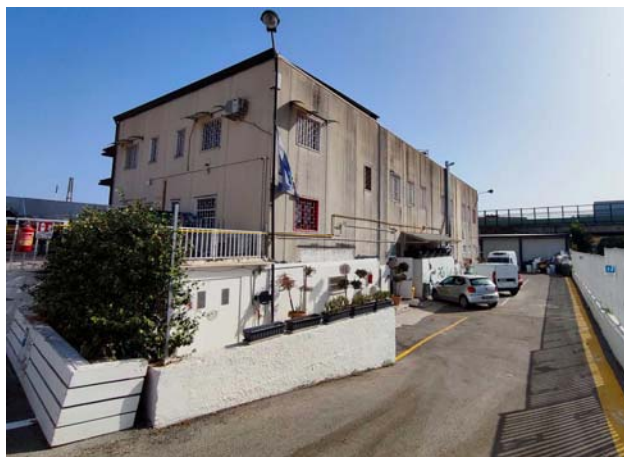
Foto 19. Spazio esterno fronte Nord
