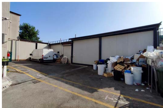
Foto 20. Spazio esterno e depositi fronte Ovest
