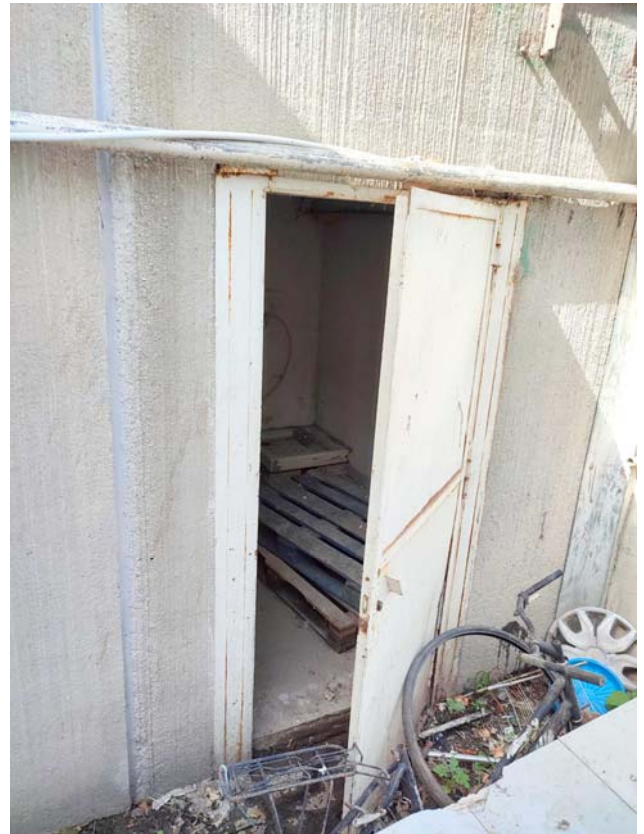
Foto 36. Ingresso al locale sub.6
