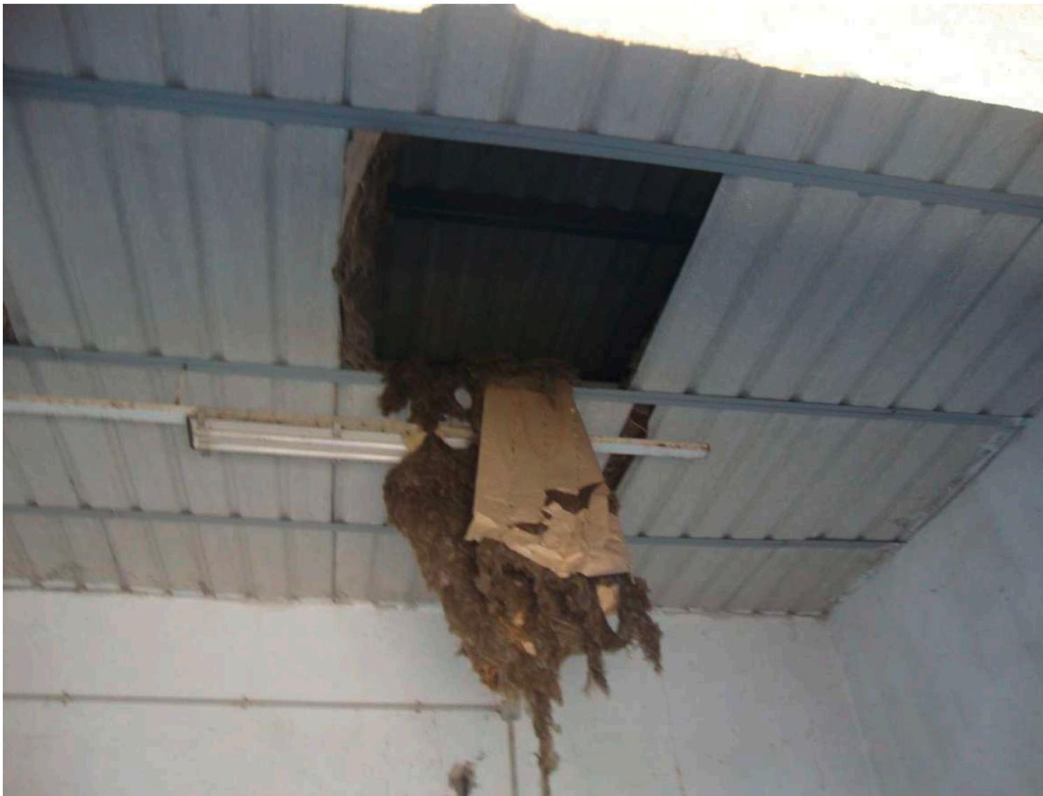
Particolari interni copertura in eternit-amianto e lana di vetro, in stato di deterioramento
