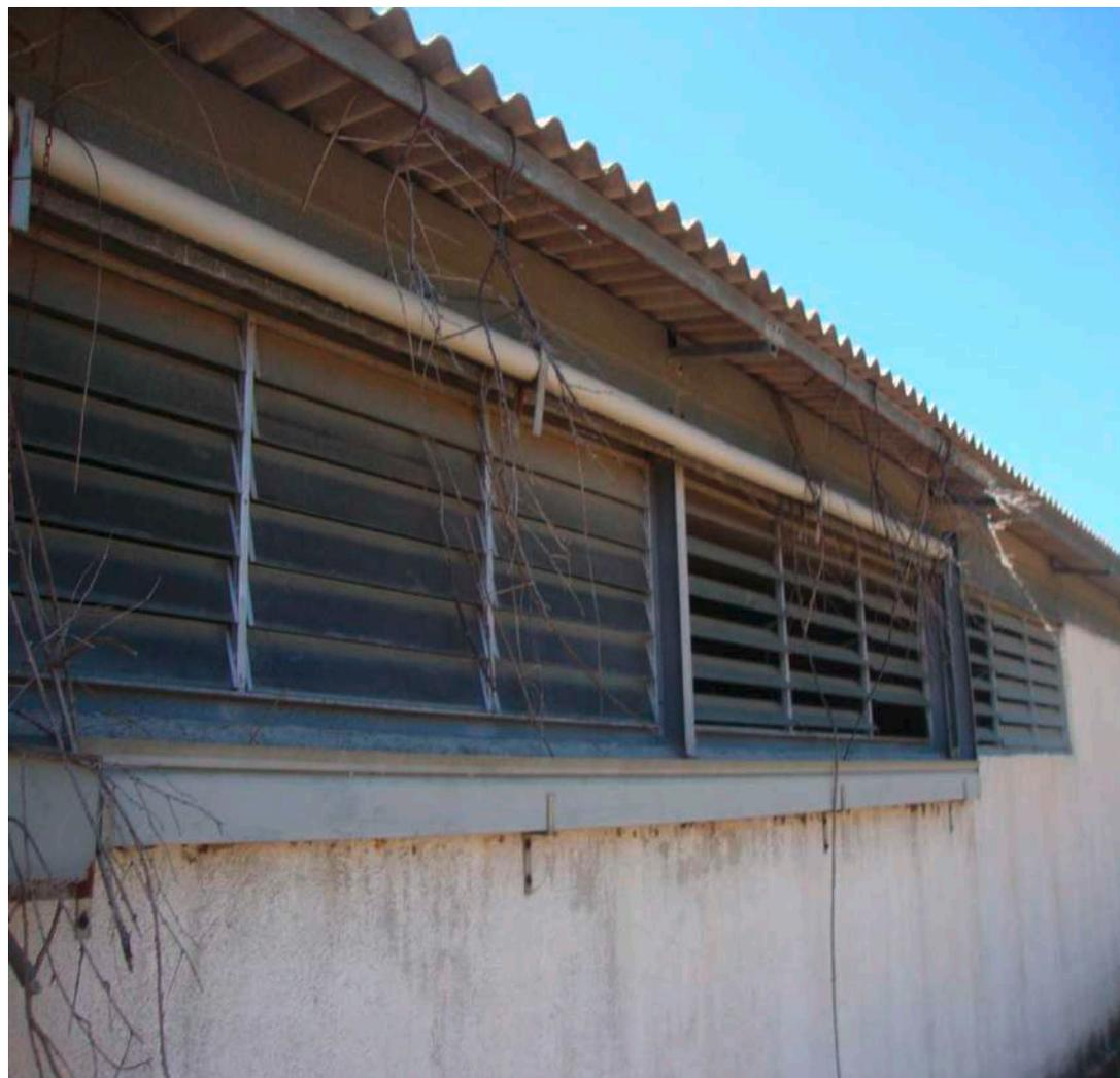
Particolare interni capannoni "allevamento polli", copertura in "eternit-amianto e lana di vetro" altamente deteriorata e cedevole, particolare aperture in vetro basculante.
