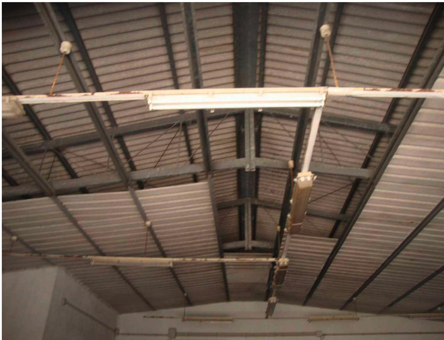
Particolari interni copertura in eternit-amianto in stato di deterioramento
