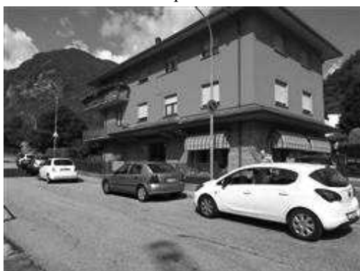
Vista generale del fabbricato su via Cerletti
