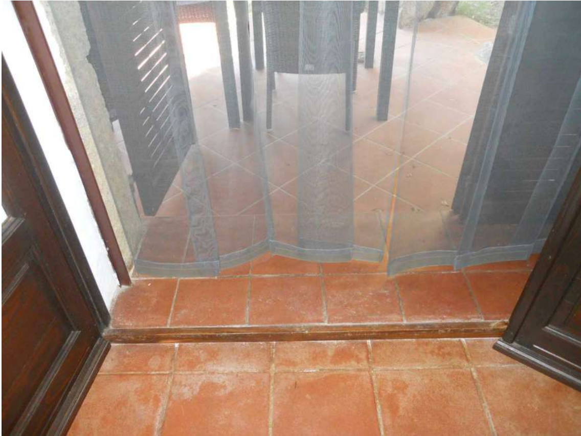
Foto 21: particolare delle soglie di ingresso.
