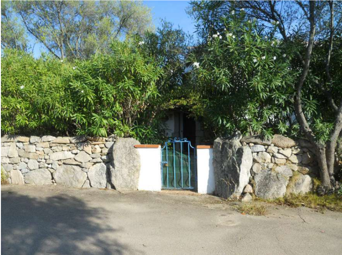
Foto 1: vista dell'accesso all'immobile dalla strada interna.
