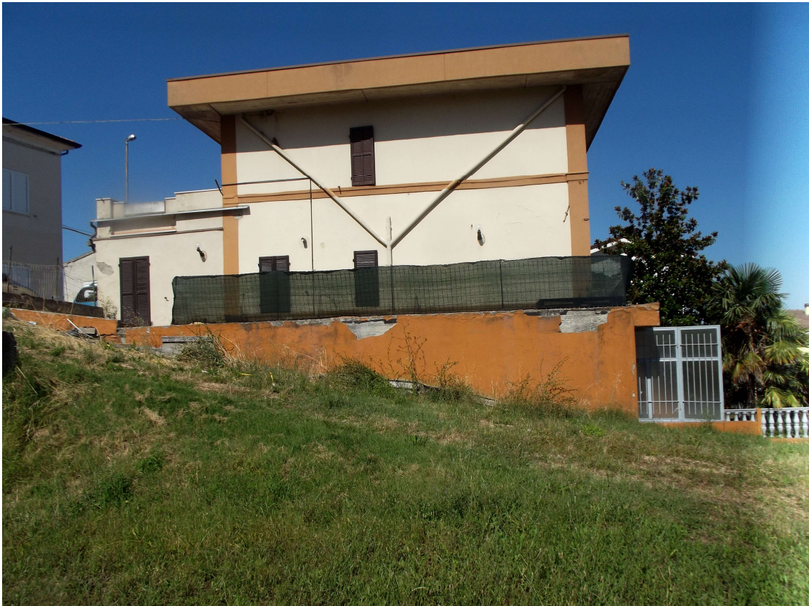
FOTO N°4: Edificio A vista esterno;
