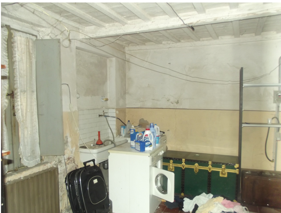
FOTO N°10: Edificio A vista Interna Piano Primo;
