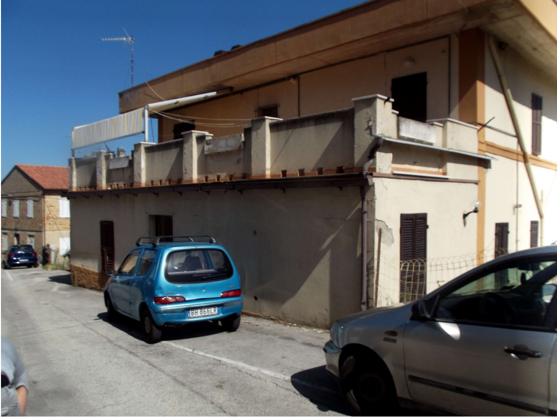
FOTO N°5: Edificio A vista esterno;
