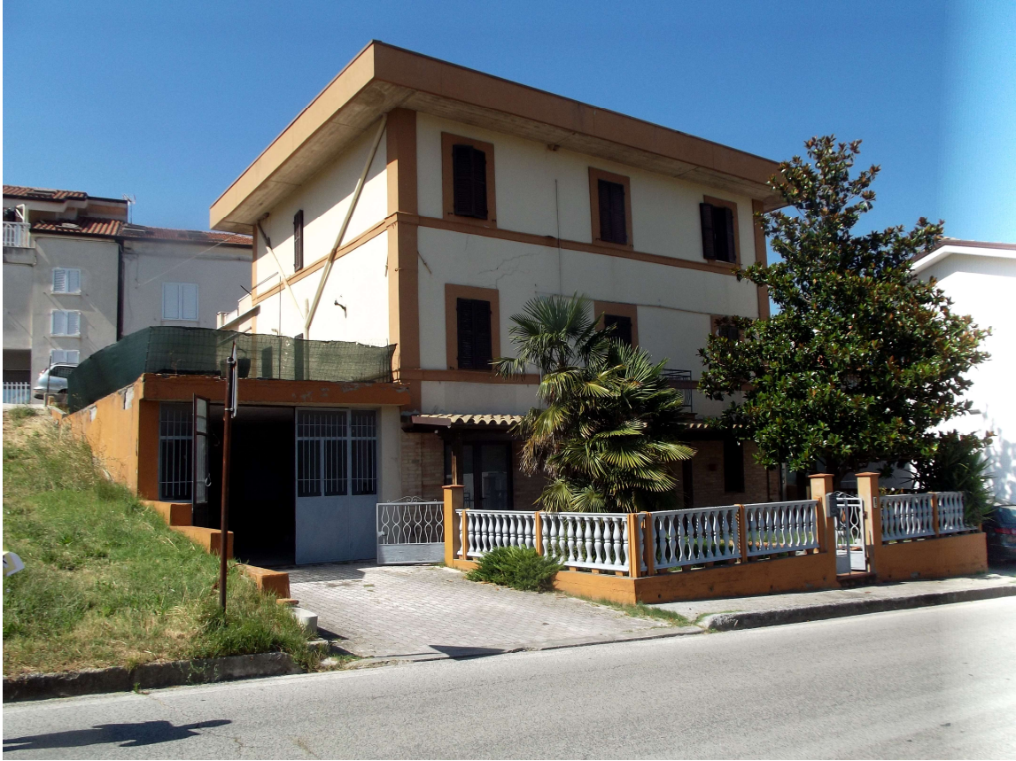
FOTO N°3: Edificio A vista esterno;
