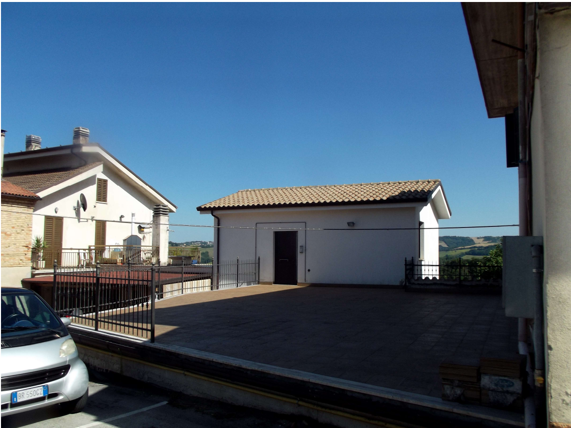
FOTO N°6: Edificio B vista esterno;
