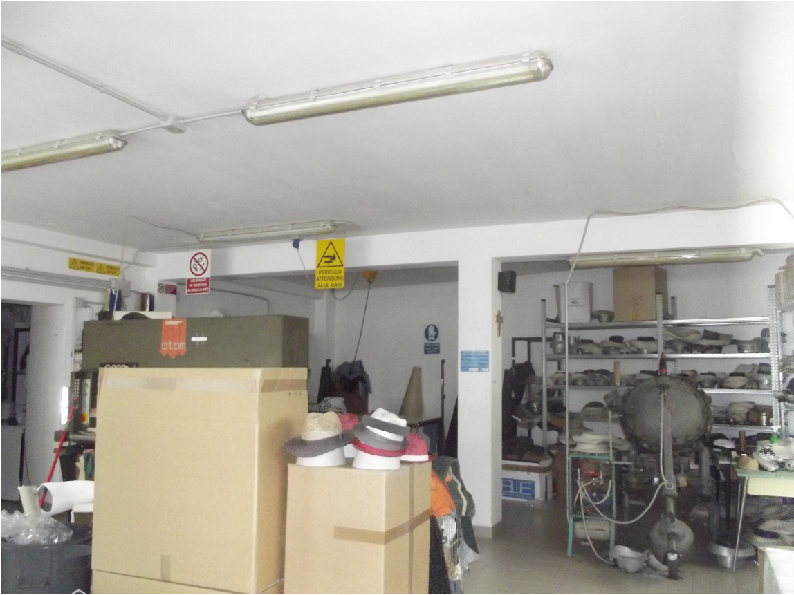
FOTO N°12: Edificio B vista Interna Piano Terra;
