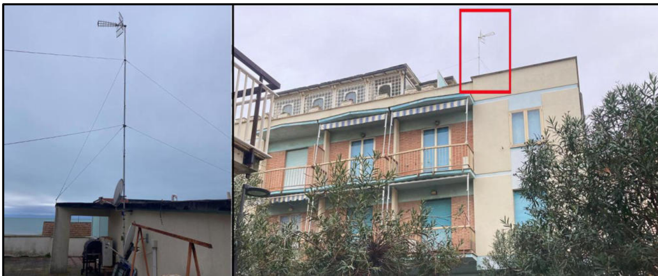
Impianto radio-televisivo: vista dell'antenna condominiale dalla terrazza comune e da via XXIV Maggio
