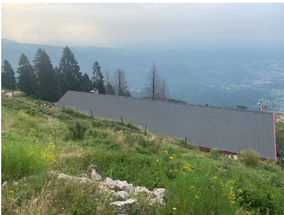
Vista dalla strada da nord.
