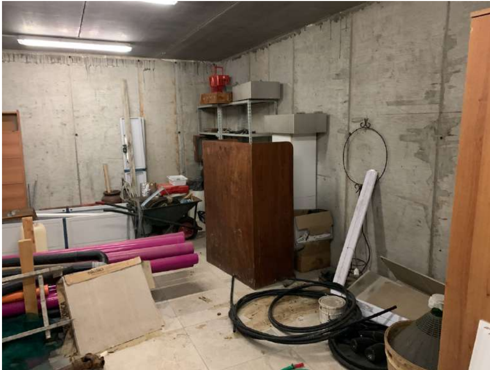
Locale tecnico a piano interrato.
