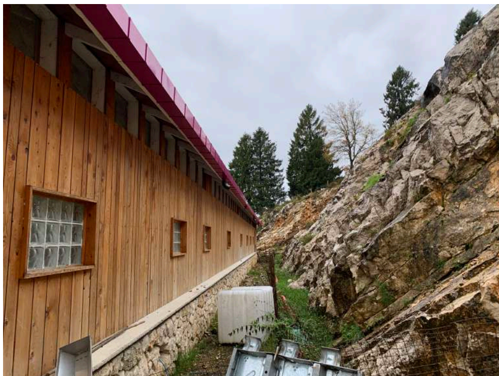
Malga, vista del fronte nord.
