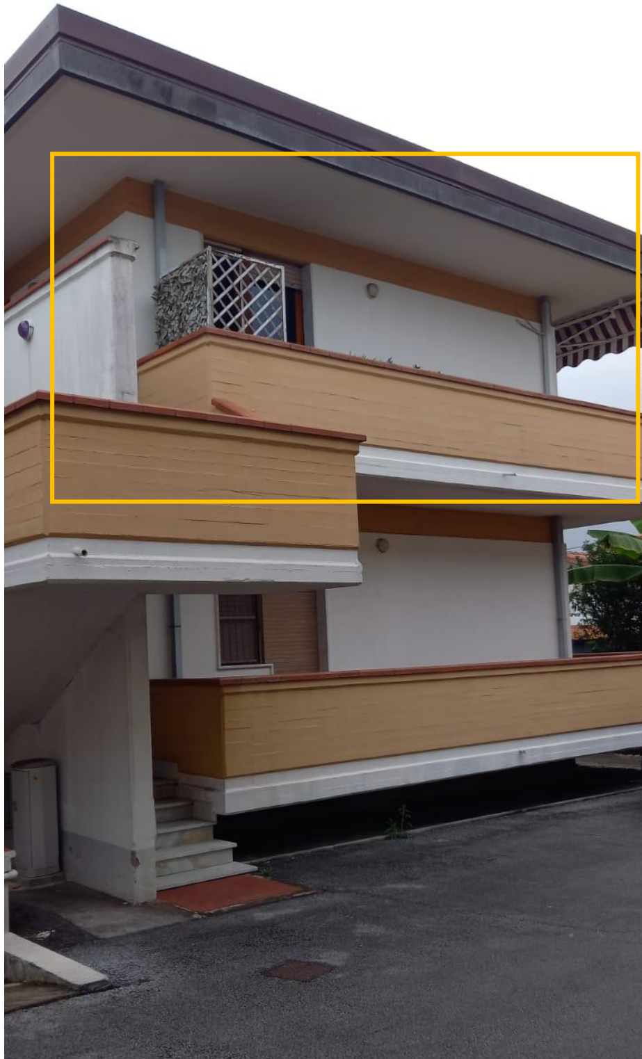
Foto 1 – Vista immobile dal viale comune
