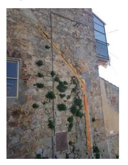
La tubazione è realizzata in rame, ma non è stato possibile accertare le caratteristiche delle tubazioni interrate, probabilmente anche quest'ultime in rame, e della rete interna, per cui non è possibile esprimere parere in merito alla rispondenza alle vigenti UNI 7129.
