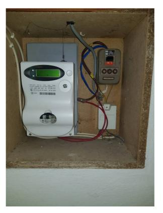
La distribuzione dell'impianto elettrico è di tipo TT e si sviluppa sottotraccia all'interno della muratura fino al raggiungimento di scatole in plastica rigida,
