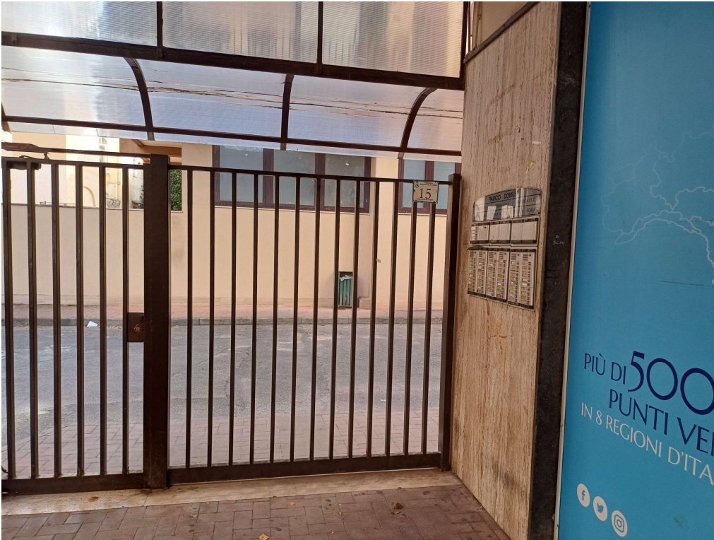
LOTTO 1 E 2 - VEDUTA DELL'INGRESSO AL FABBRICATO
