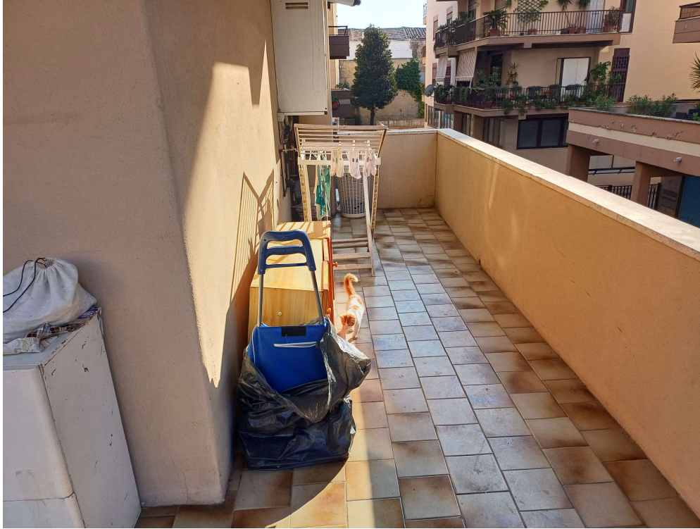
LOTTO 2 - VEDUTA DEL TERRAZZO LATO STRADA
