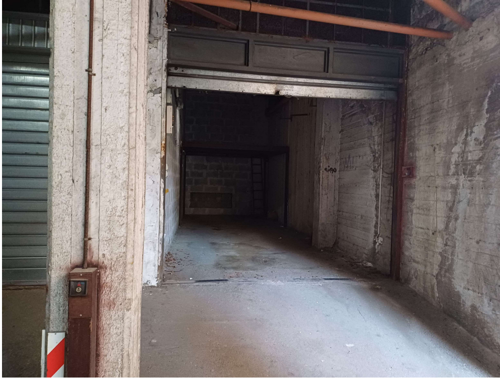
LOTTO 3 - VEDUTA DEL BOX AUTO DALLA CORSIA DI MANOVRA
