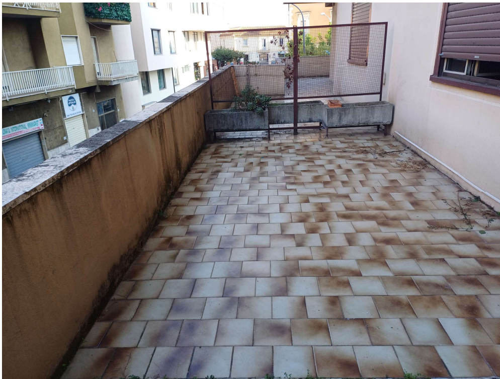
LOTTO 2 - VEDUTA DEL TERRAZZO LATO STRADA
