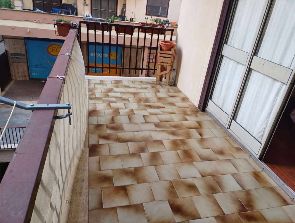
LOTTO 1 - VEDUTA DEL BALCONE LATO CORTILE
