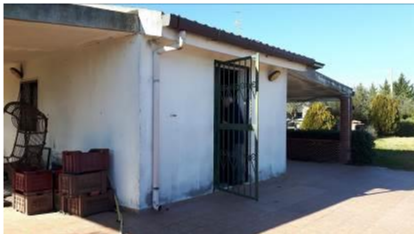
Immobilie n. 1 – Accesso al deposito
