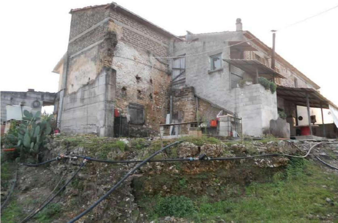
Foto 3 esterno - Prospetto posteriore
