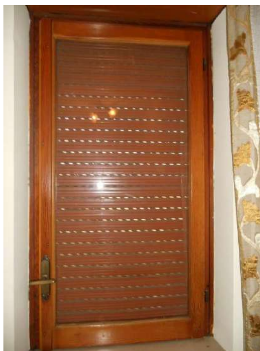
Foto 16 interno - Infisso Finestra
