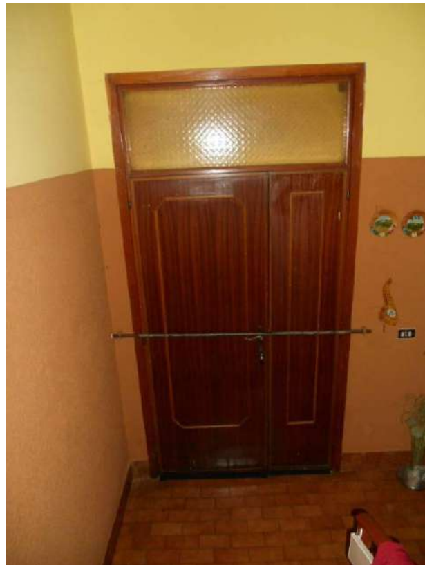
Foto 8 interno - portone ingresso
