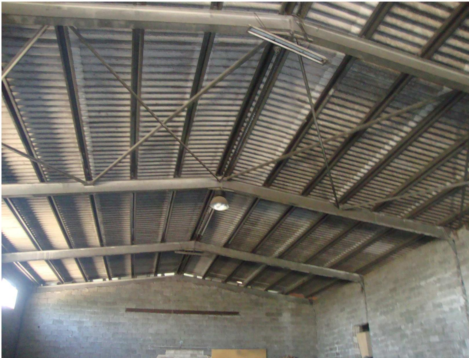
Particolare copertura in elementi di carpenteria metallica e lastre di fibrocemento.
