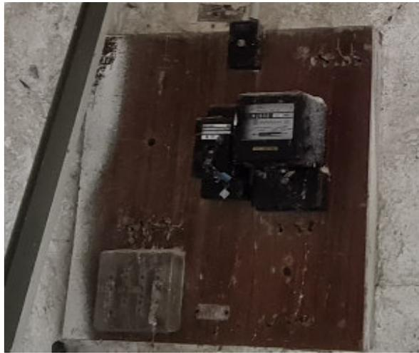
A tale dispositivo sono collegati conduttori che, tramite canalina in PVC, raggiungono il quadro elettrico di distribuzione, posizionato accanto al contatore Enel, realizzato con centralino in resina a parete dotato di sportello di chiusura, al cui interno è presente:
