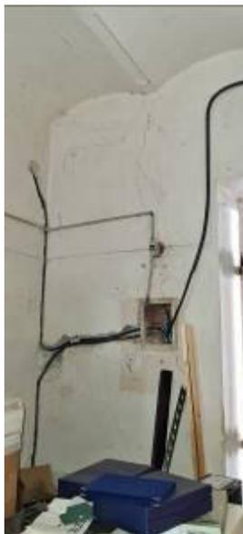
L'impianto elettrico presente si sviluppa principalmente in canalina esterna in PVC e sono stati rilevati interruttori magnetotermici a protezione di qualche linea elettrica, ma lo stesso è privo di interruttori differenziali, inoltre sono stati rilevati dei dispositivi di connessione delle condutture in vista, con possibilità di accesso alle parti attive, e delle giunzioni realizzate con semplice nastratura per cui, per tali elementi, non è garantita la protezione contro i contatti diretti.
