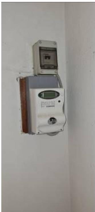
A tale dispositivo sono collegati conduttori che, tramite corrugato a vista, raggiungono il quadro elettrico di distribuzione, posizionato sopra il dispositivo di misura, realizzato con centralino in resina a parete dotato di sportello di chiusura, al cui interno è installato un interruttore bipolare magnetotermico-differenziale, marca ABB, modello D642 C25 da 25A con potere di interruzione di 4,5 kA e con soglia di sensibilità di 0,03A
