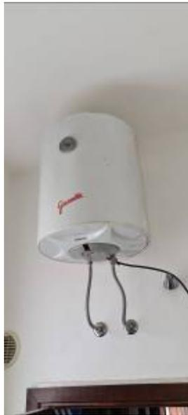
Mentre nella cucina la produzione dell'acqua calda sanitaria avviene tramite uno scaldabagno elettrico, installato a parete, marca Ariston, Modello ANDRIS RS 10/3 EU, da 10 litri e con potenza termica di 1,2 kW.
