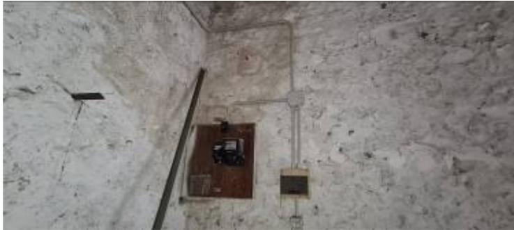
La distribuzione dell'impianto elettrico all'interno dell'appartamento è di tipo TT e si sviluppa a vista, tramite tubazione in PVC, fino al raggiungimento di scatole in plastica rigida, con funzione di porta-frutto (interruttori, prese).
