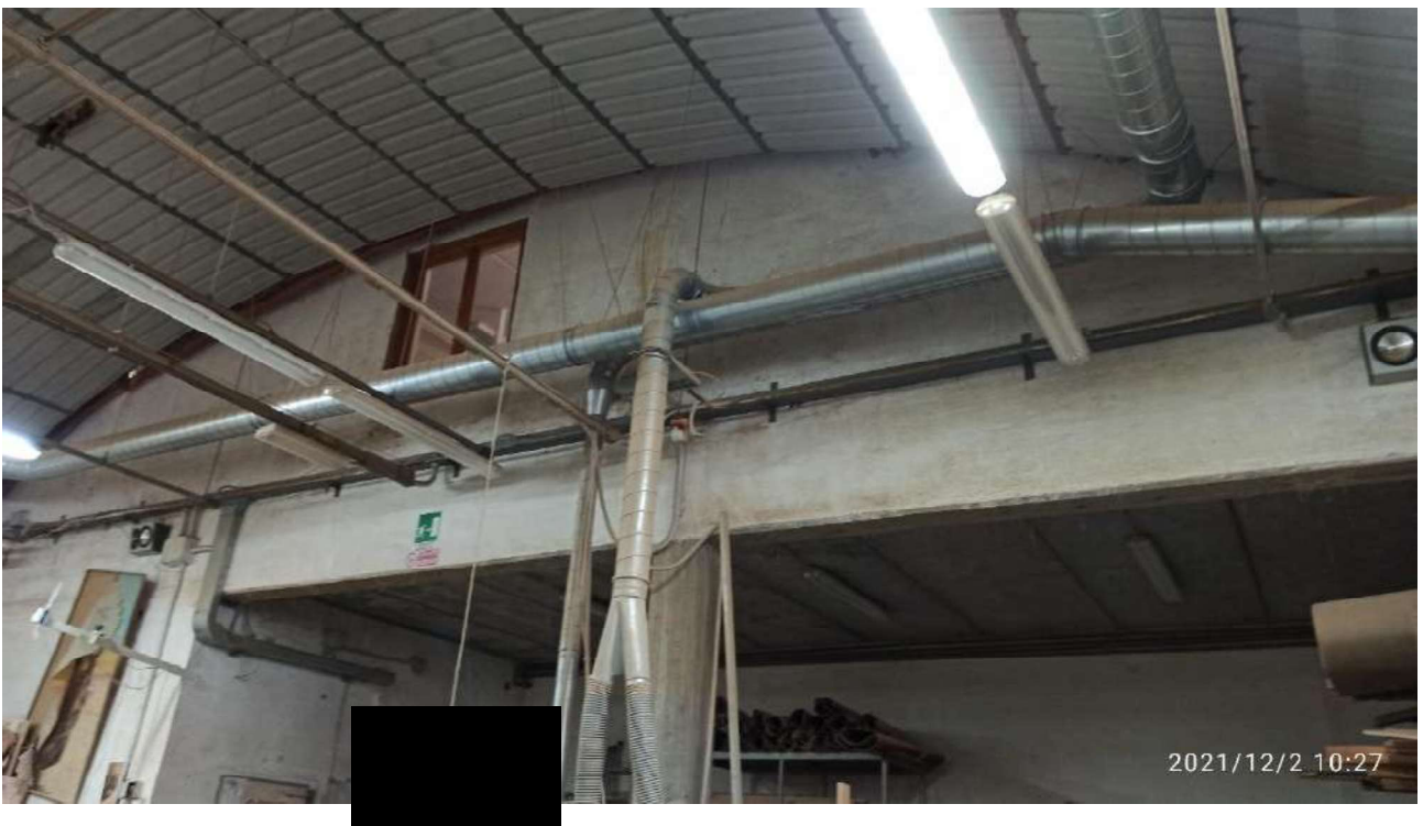
Foto n. 8 – interno opificio con andamento della copertura
