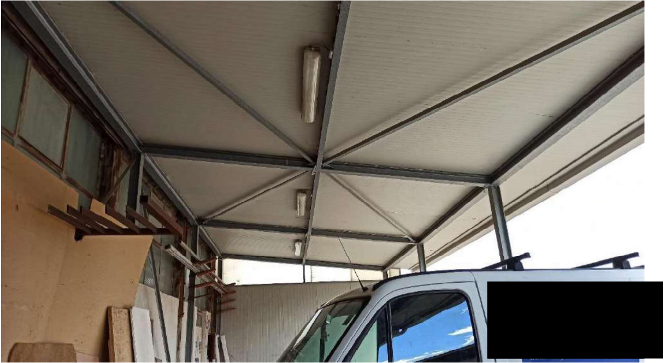
Foto n. 16 – Interno tettoia rif. lettera “D” dello schema
