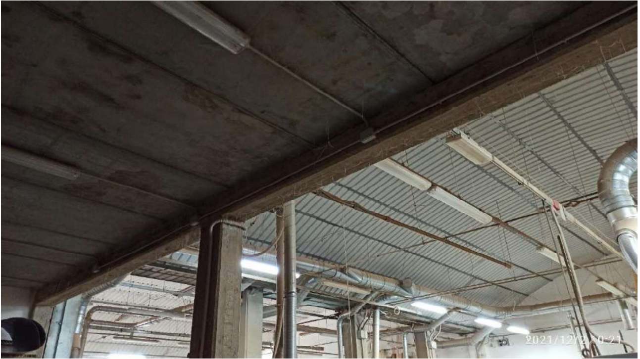
Foto n.ri 9 e 10 – particolare strutturale del fabbricato
