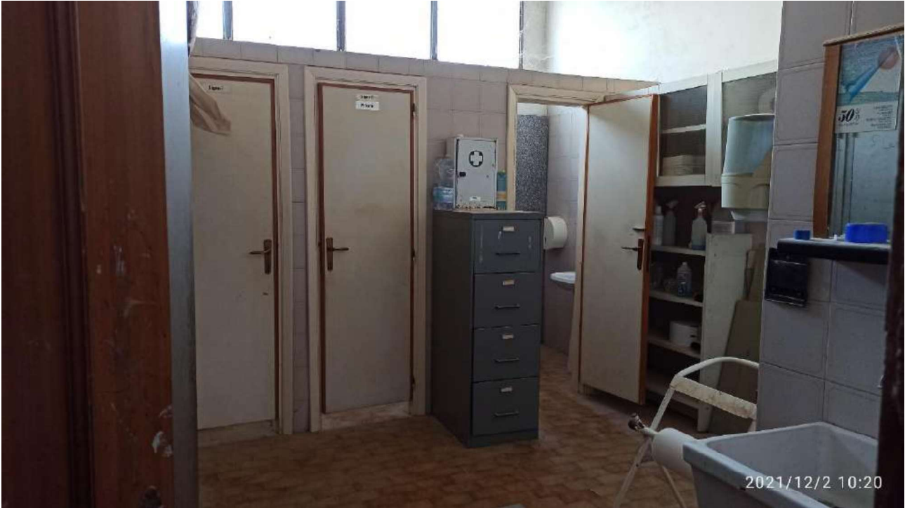
Foto n. 11 – locale spogliatoio e servizi annessi all’opificio
